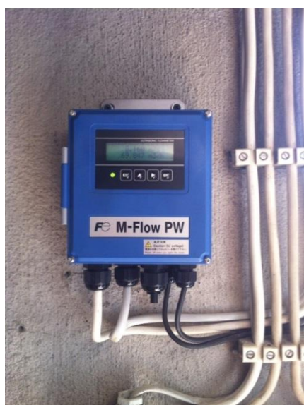
KUVA 14. M-Flow PW –virtausmittauksen vahvistin kytkettynä Neulamäen pumppaamolla (valokuva Iiro Karppinen.)
