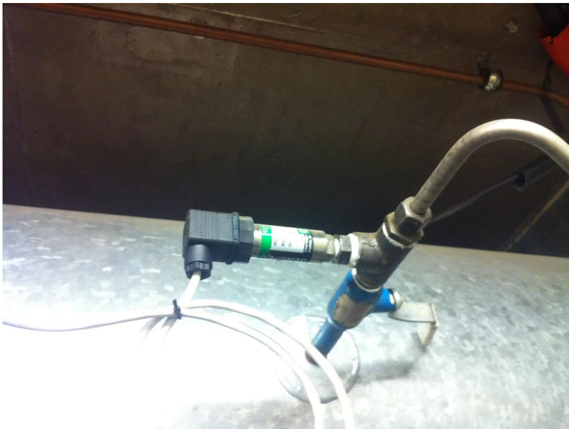
KUVA 16. WIKAn -panielähtin asennettuna Neulamäen pumppaamolla (valokuva Iiro Karppinen.)
