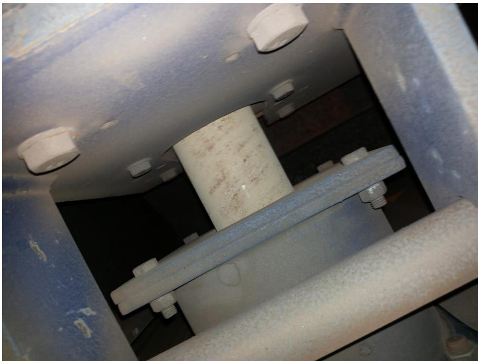
Kuva 22. Nuohoimen suutinputken meno kattilaan, josta lämpötilat on mitattu.
