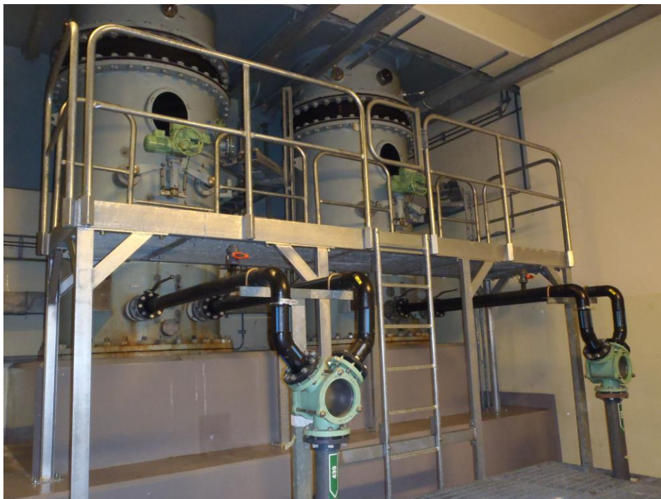
Kuva 5. Taprogge-laitteisto (Talonpoika sähköposti 06.02.2015)
