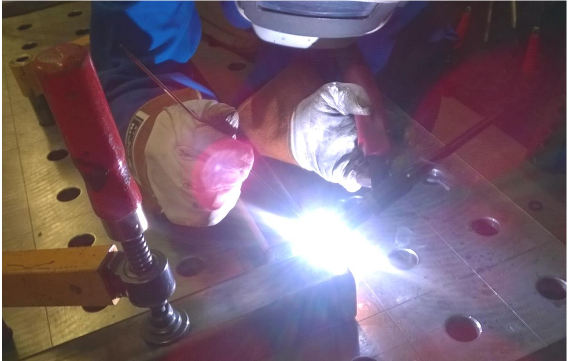
Kuva 13. Rungon pääprofiilit hitsattiin TIG-hitsausmenetelmällä.
