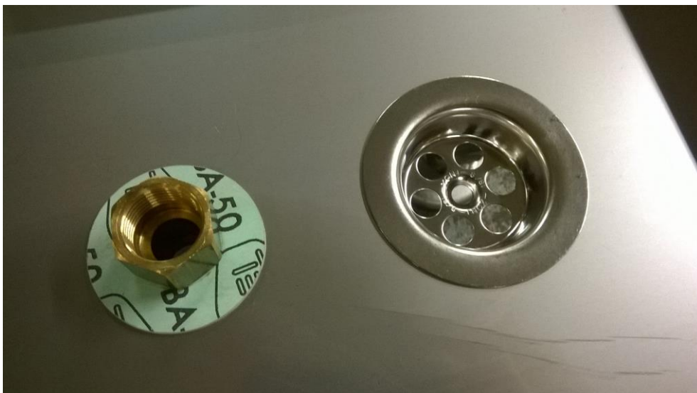
Kuva 20. Vesialtaan pohjaan asennettiin vesihana ja viemäri-lähtö.
