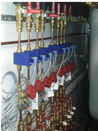
Kuva 43. Bauereihe VMZ -virtausmittarit paluuputkeen asennettuna. (Kuva tekijän.)
