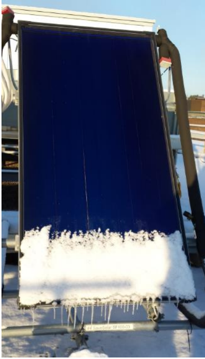
Kuva 37. Tasokeräin SavoSolar SF 100-03. (Kuva tekijän.)
