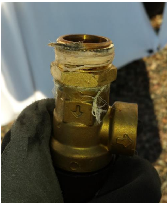
Kuva 45. Virheellinen hamppu-tiivisteiden käyttö putken kierrelliitoksessa. (Kuva tekijän.)
