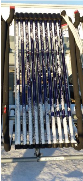
Kuva 36. Tyhjiöputkikeräin SunPur NN10. Kuva tekijän.
