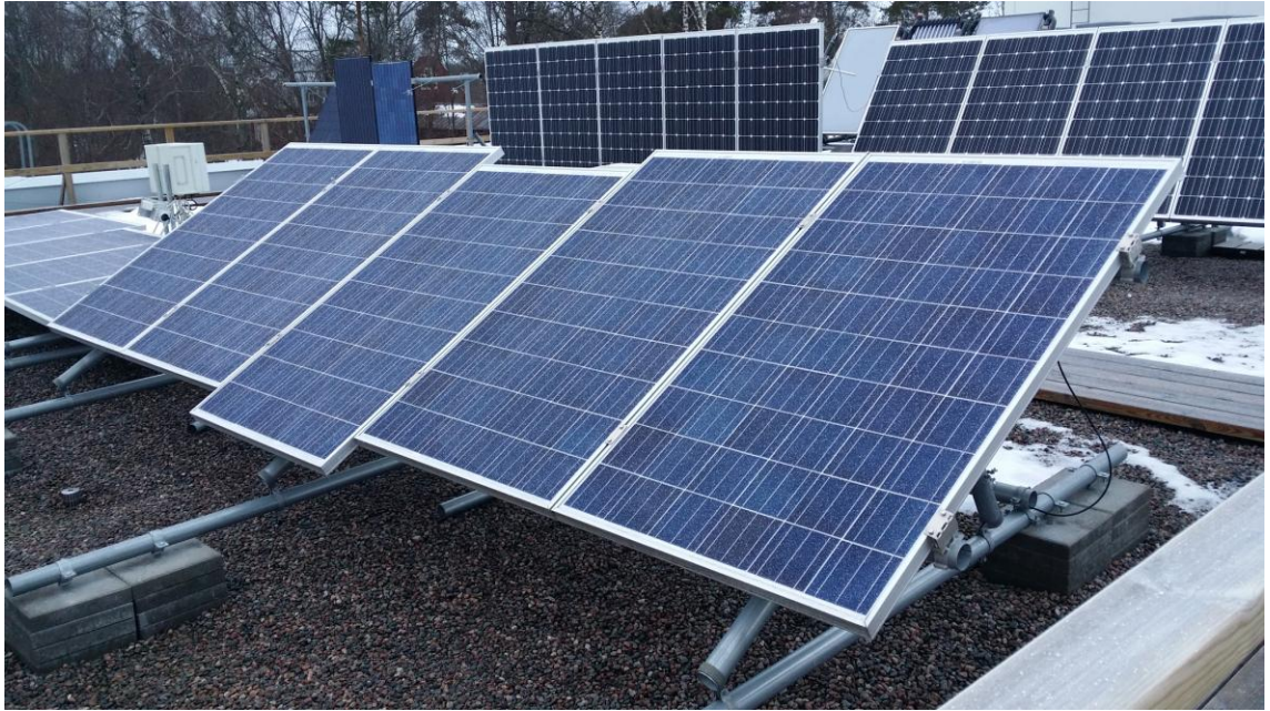
Kuva 33. MetroSol-aurinkoenergielaboratorion aurinkopaneelistot. Eturivissä monikidepaneelit (Innotech Solar - ITS EcoPlus 240W), takarivissä yksikidepaneelit (SolarWATT M250-60 AC 05).
