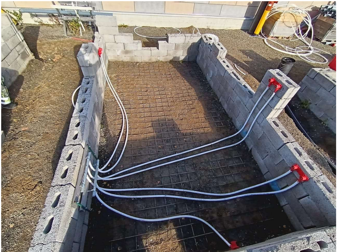
KUVA 19. Talo numero 2, jossa on toteutettu käyttövesijärjestelmän asennus.
