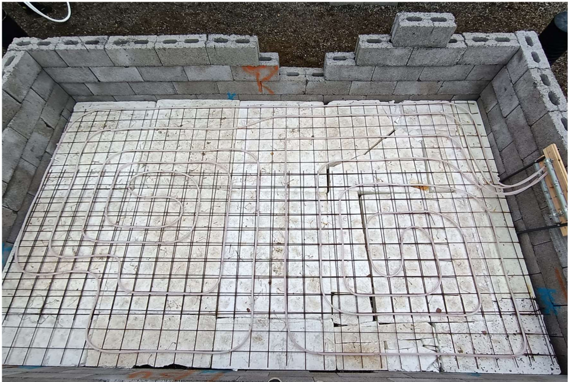
KUVA 20. Talo numero 3, jossa on asennettu lattialämmitys piirit.
