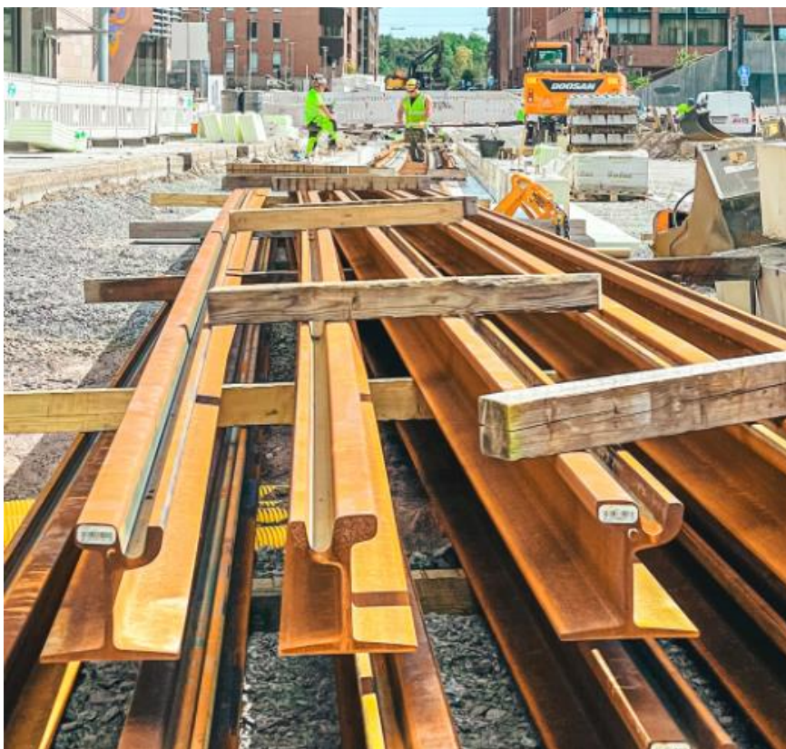
KUVA 6. Kiskojen säilytys työmaalla (Mortaza Hashimi 2022).
