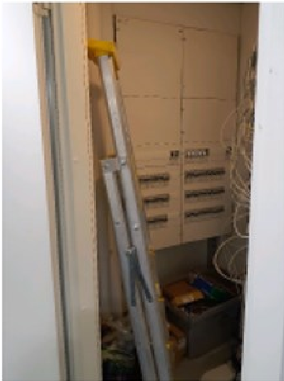
Kuva 8. Sähkötilassa varastoituna runsaasti sinne kuulumatonta tavaraa.
