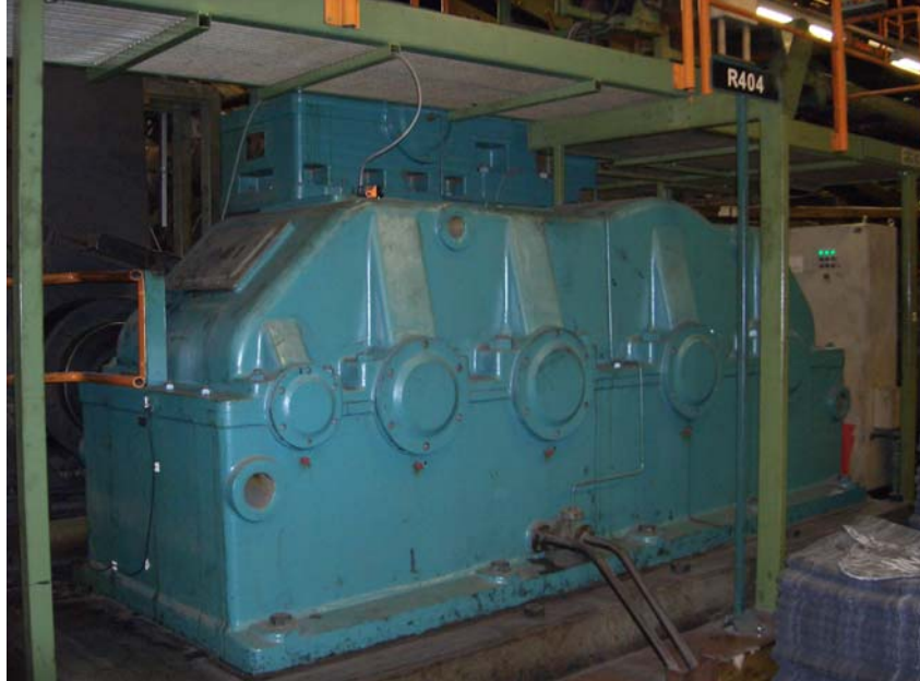
Kuva 10. Päävaihdelaatikko käytävän puolelta./5/
