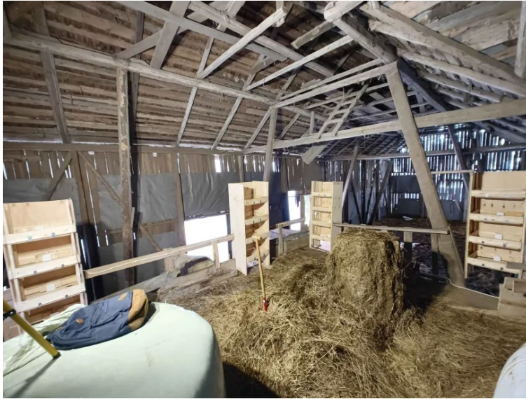
Kuva 11. Syöttimet ladon yläparvelle asennettuina
