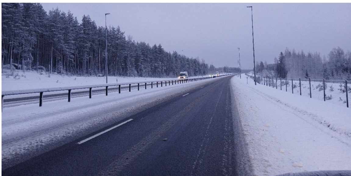
Kuva 14. Valtatie 6 formiaattialue 28.1.2025 (Kuva: Lauri Heija)
