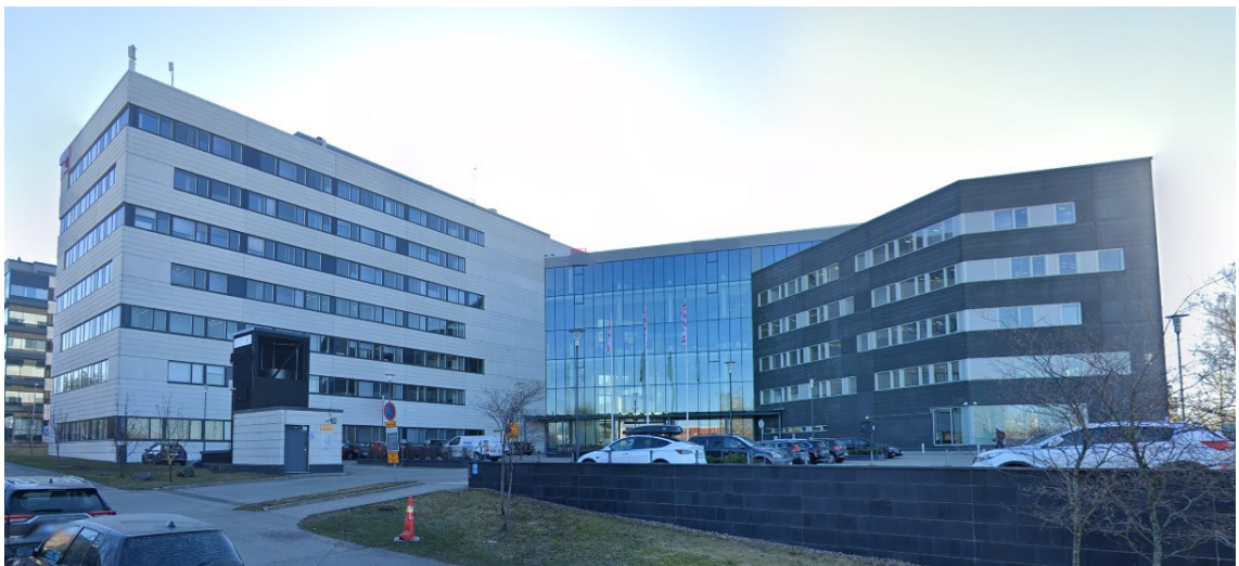
Kuva 1. Kiinteistön julkisivu pääsisäänkäynnin puoleiselta sivulta.
