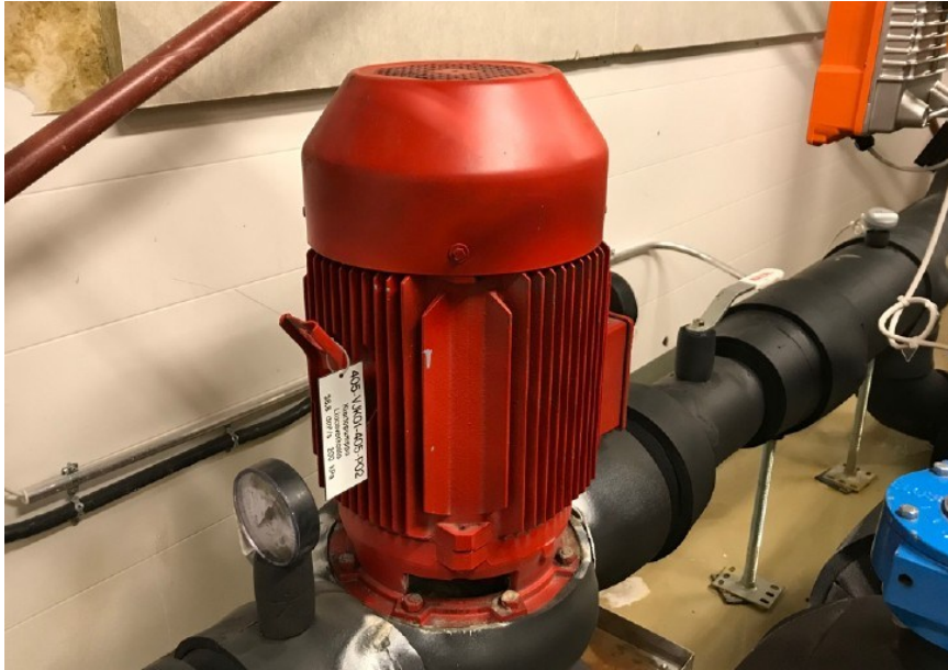
Kuva 23. Liuospiirin pumppu 405-VJK01-405-P02.
