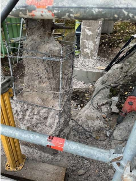
Kuva 4. Betonipilareiden vahvistus (Kuva: Joni Lemmetyinen 2025)
