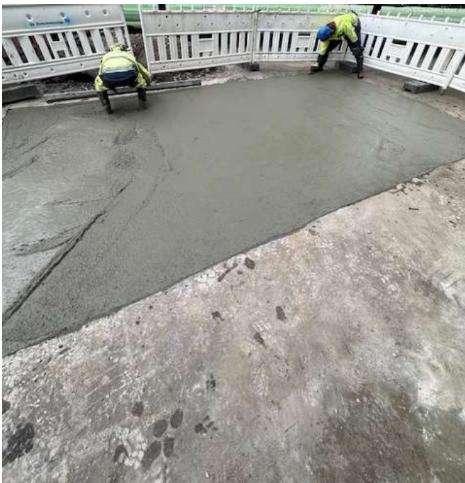
Kuva 7. Vallitilan betonointi (Kuva: Joni Lemmetyinen 2025)
