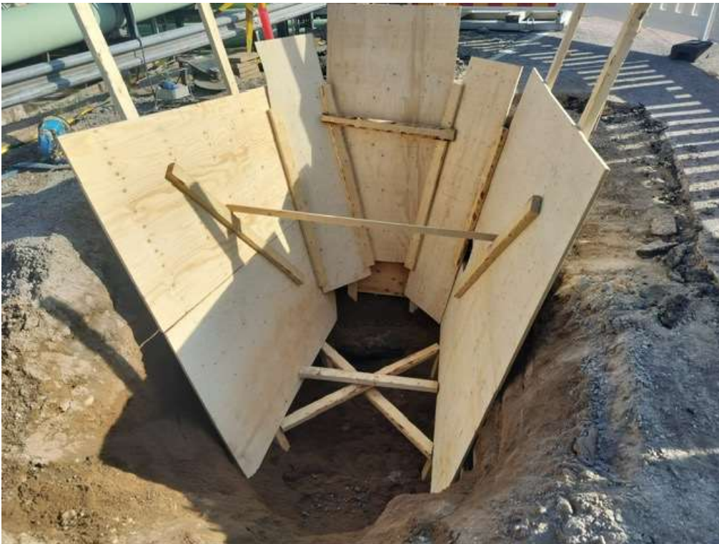
Kuva 3. Palovesilinjan vuoto (Kuva: Joni Lemmetyinen 2025)
