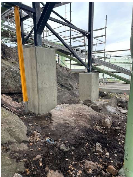
Kuva 6. Betonipilareiden vahvistus (Kuva: Joni Lemmetyinen 2025)
