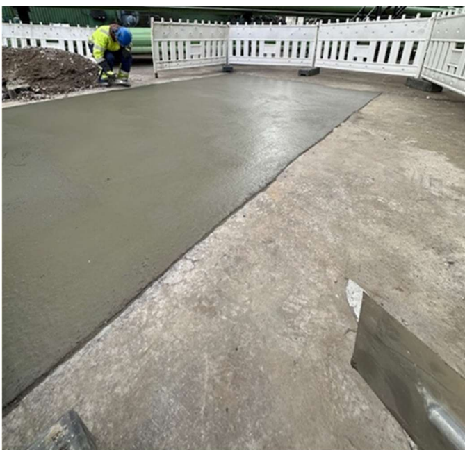
Kuva 8. Vallitilan betonointi (Kuva: Joni Lemmetyinen 2025)
