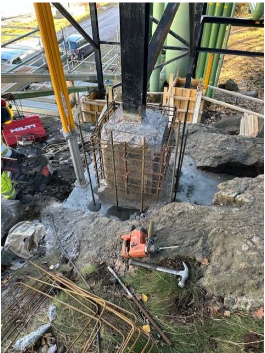
Kuva 5. Betonipilareiden vahvistus (Kuva: Joni Lemmetyinen 2025)
