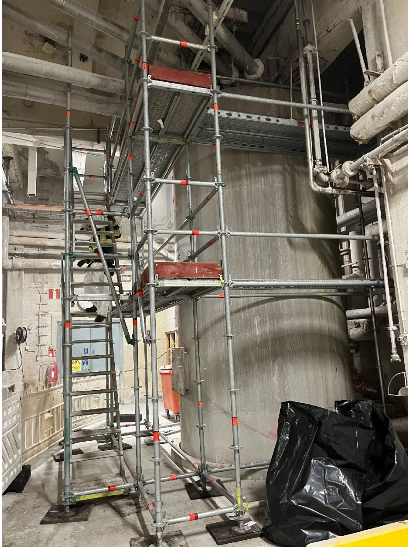
Kuva 8. Layher-rakennustelineet vesisäiliön ympärillä
