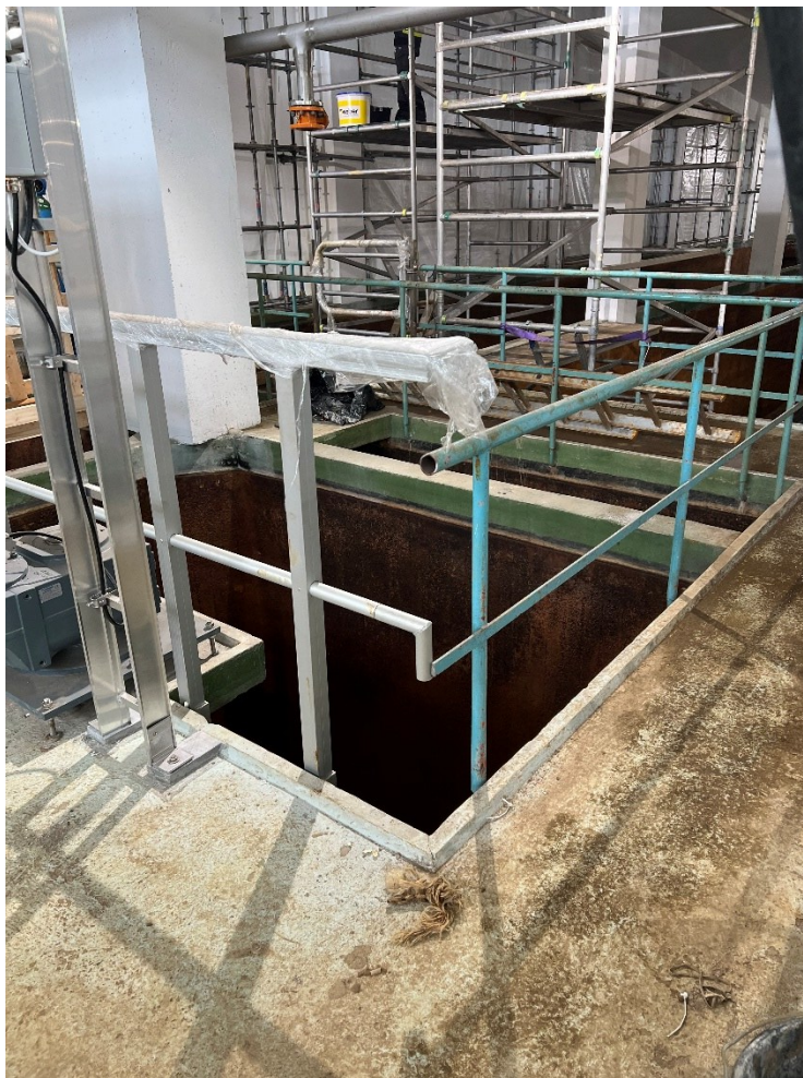
Kuva 2. Laitoksen vanhat ja uudet kaiteet vierekkäin
