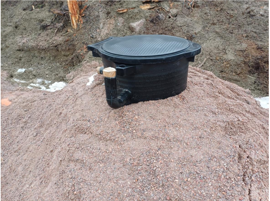
KUVA 22. Mittakaivo asennettuna jätevedenpurkulinjaan (Ala-Hiiri).
