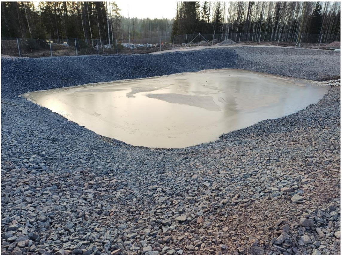
KUVA 7. Valmis viivytytsallas, jonka viivytytskapasiteetistä käytössä noin 30 % (Ala-Hiiri).
