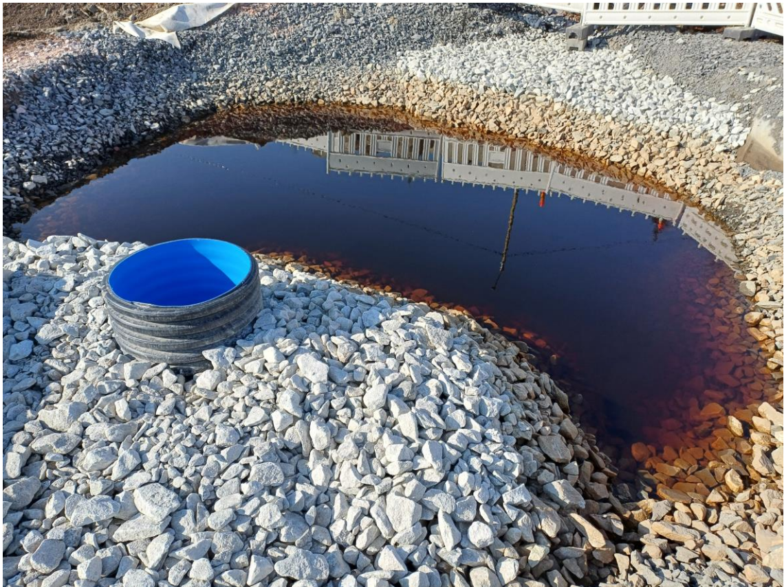
KUVA 8. Pieni viivytsallas pumppukaivolla sekä kalkkikivellä (Ala-Hiiri).
