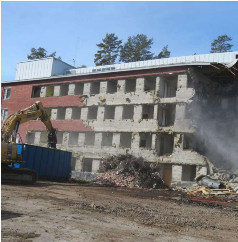
Kuva 5. Tiilijulkisivun erillinen purkaminen (Raimo Lilja)
