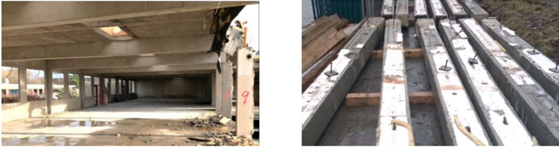
Kuva 9 Kantavat betonirakenteet uudelleenkäyttöön (CIRCuiT 2022.)
