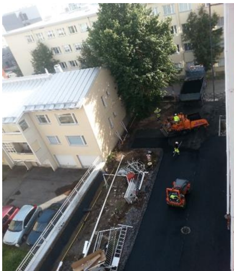
KUVA 12. Pihan asfaltointi, Kuninkaankatu 29 (Räsänen, 2014-07-05)
