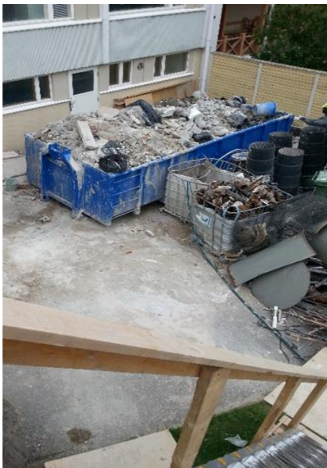
KUVA 4. Työmaan roskalava. As. Oy Kuninkaankatu 29 (Räsänen 2014-06-05.)
