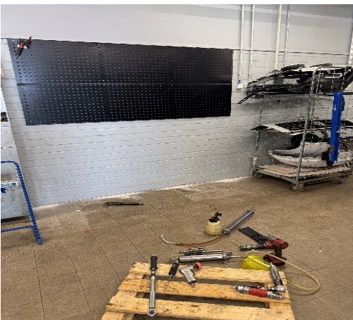
Kuva 5. Työkaluseinä asennettuna kaappien tilalle.
