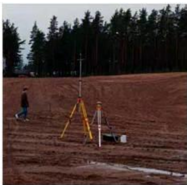
Figur 4; Avvägning av gräv djupet vid täktområde. (Miljöministeriet, Bild från täktområde, 2009, s.46)
