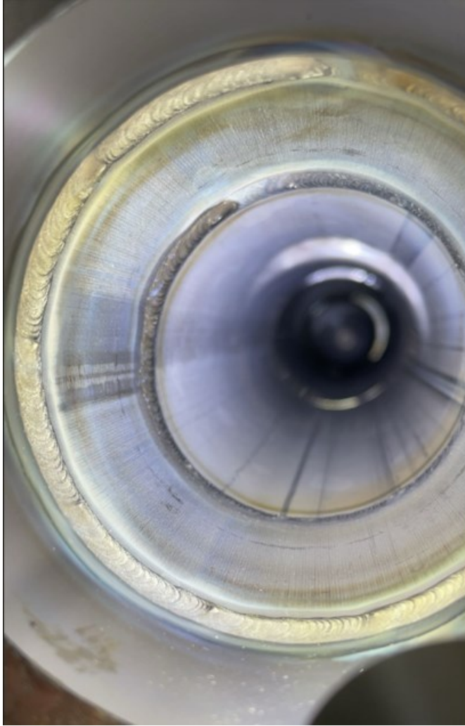
Kuva 7. Formierilla suojattu juuripuoli ruostumattoman teräksen putkihitsauksessa.
