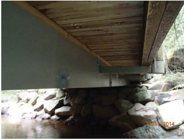
KUVA 11. Hevosreitlin sillan palkit ovat taipuneet
