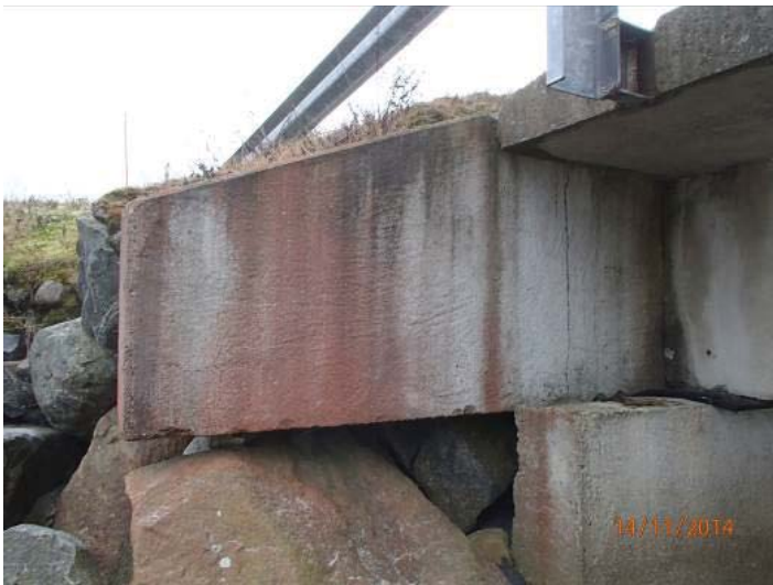
KUVA 20. Siipimuurit ovat tyhjän päällä
