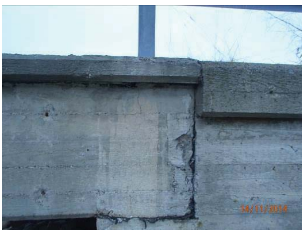
KUVA 27. Kansilaatan päät ovat lohkeilleet
