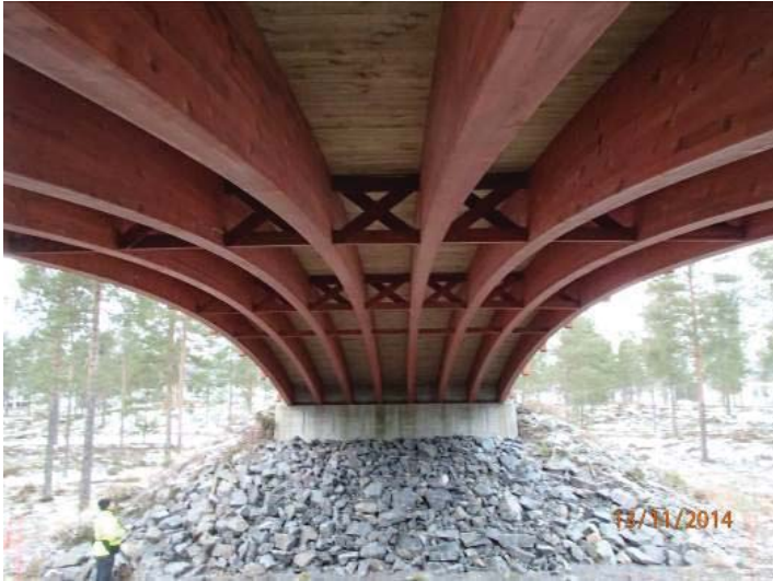
KUVA 36. Usvametsäntien eteläisempi latusilta alapuolelta kuvattuna
