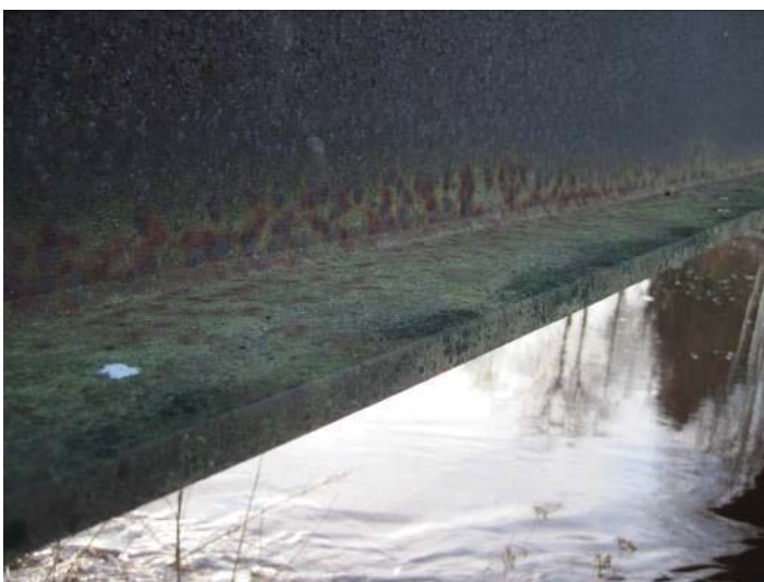
KUVA 14. Koulusillan palkit ovat corten-terästä
