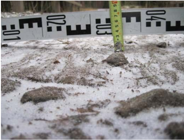
KUVA 12. Maankaatopaikan sillan kansi on kulunut ~30 mm
