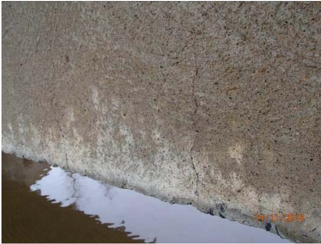
KUVA 22. Palkin alapinnassa on halkeamia
