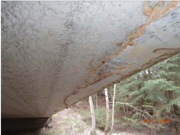
KUVA 26. Kansilaatan korroosio
