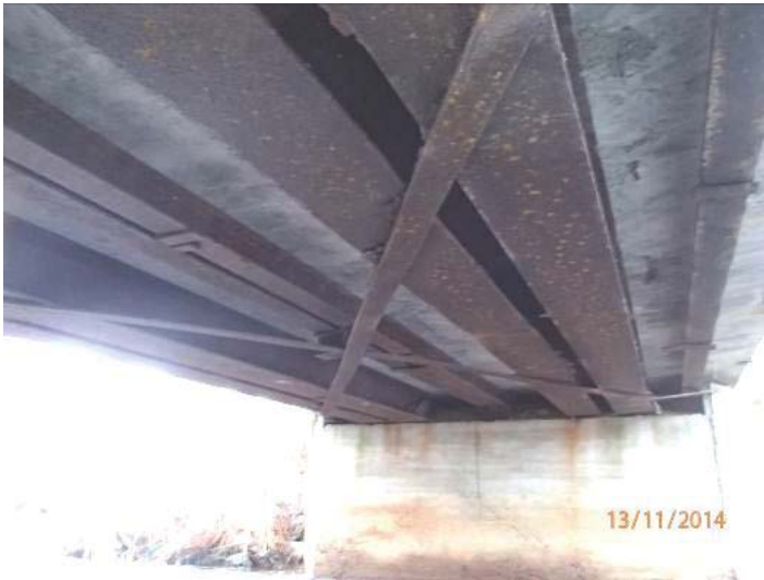
KUVA 15. Pohjanpuolentien sillan pääkannattajapalkit
