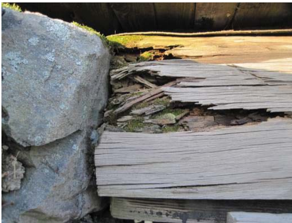
KUVA 40. Puuverhouksen lahovaurio
