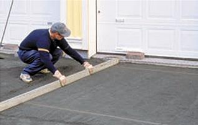
KUVIO 3. Asennushiekan tasaus (betonilaatta.fi)
