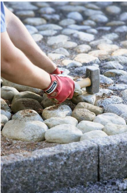
KUVIO 5. Kenttäkiveyksen rakentaminen (viherpiha.fi)
