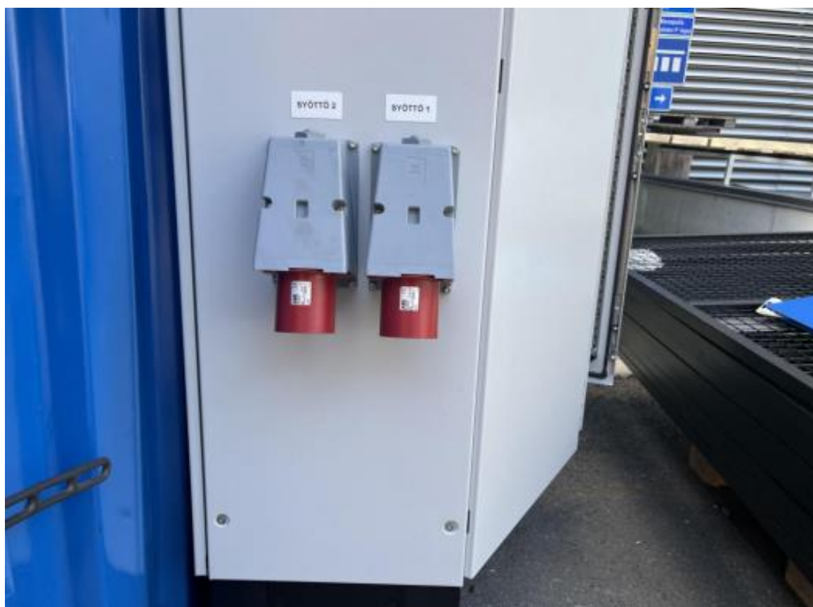
Kuva 12. Kuva syöttöliittimistä (Neuvonen, 2023.)
