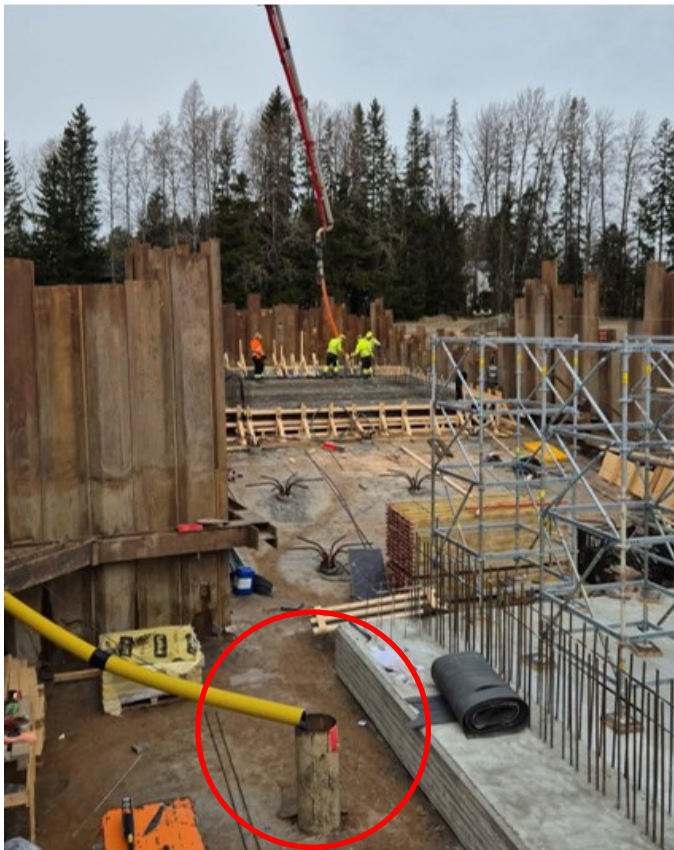
Kuva 12 Valutyöt käynnissä (Skanska Infra Oy)
