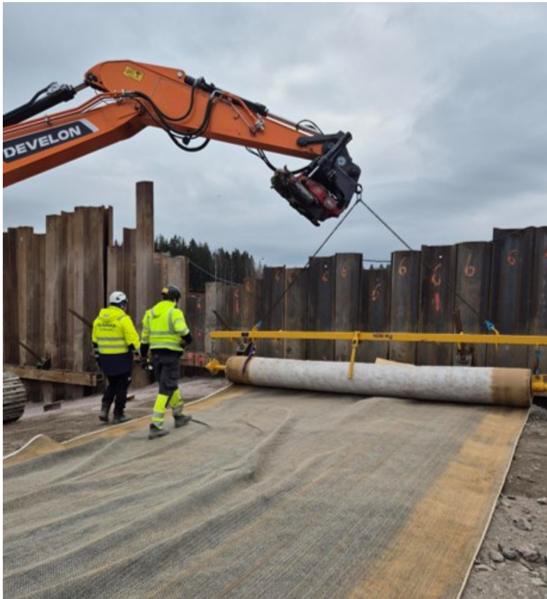
Kuva 11 Bentoniittimaton levitys (Skanska Infra Oy)
