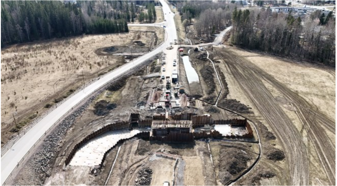
Kuva 9 Ilmakuva siltapaikasta (Skanska Infra Oy)
