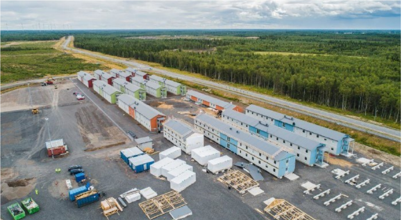
Kuva 1 HVM Infran toimittamat modulaariset työmaamajoitukset, (M Raksa Service Oy, 2025).
