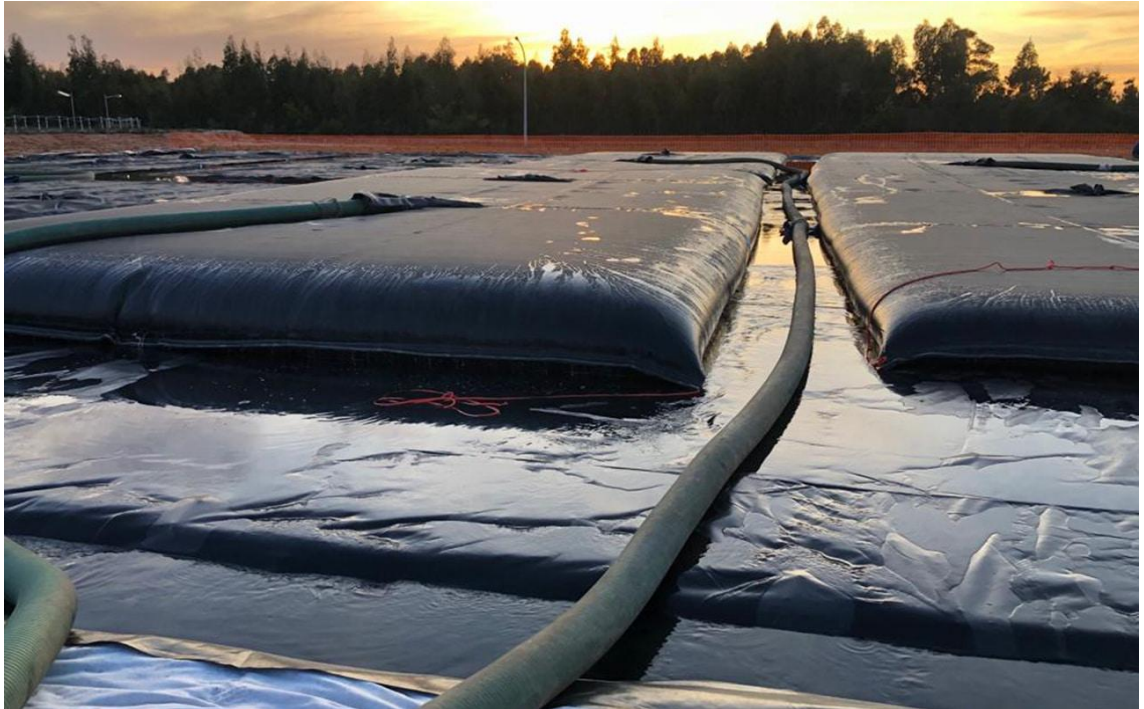
Kuva 8. Geotuubeja (Ambitrevo LDA) [19]
