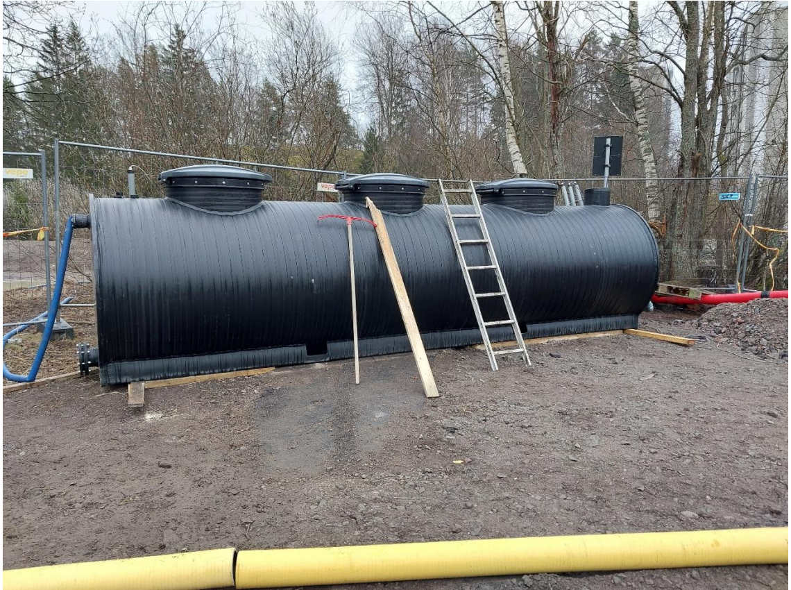
Kuva 18. Uponor-vedenkäsittelyjärjestelmä (Mikko Rynnänen)
