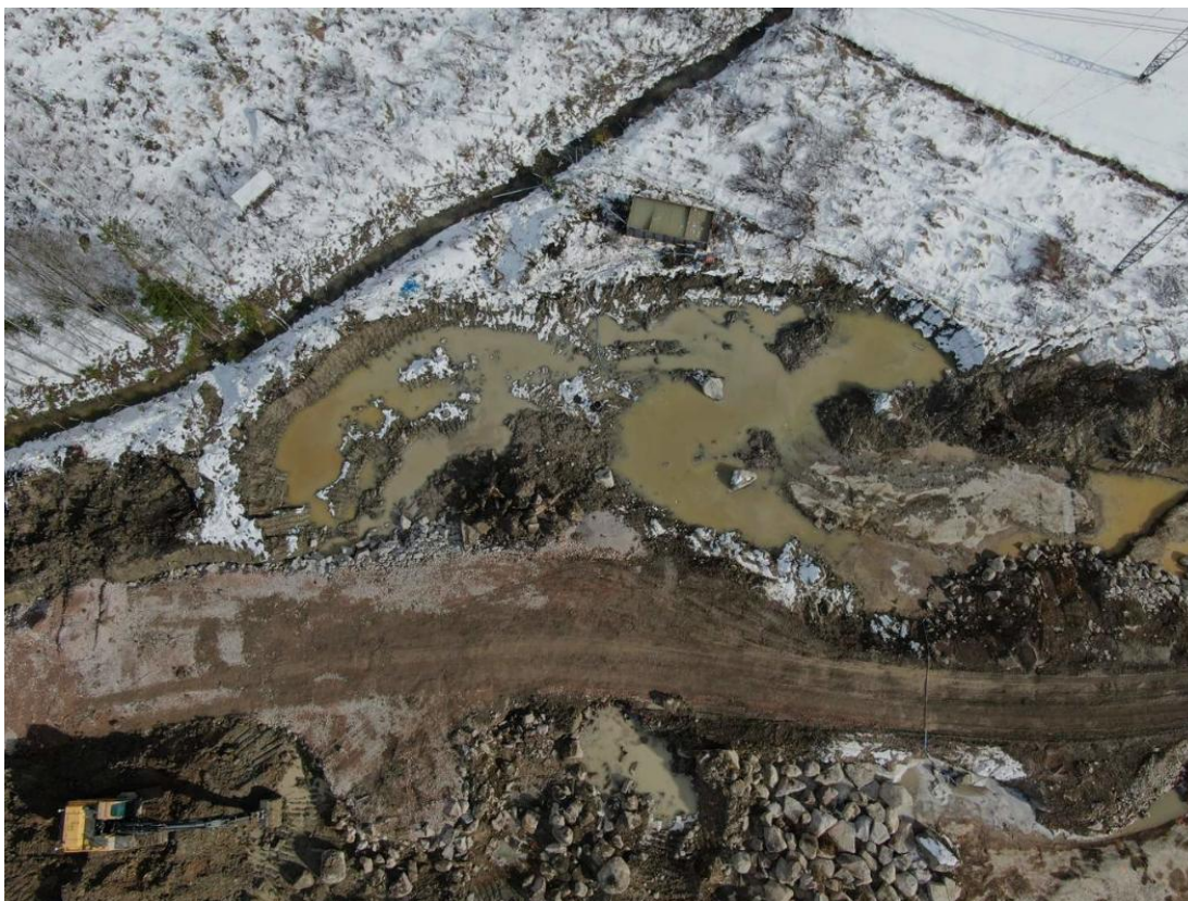
Kuva 1. Työmaavesiä kaivannoissa (Eero Lahtela) [7]
