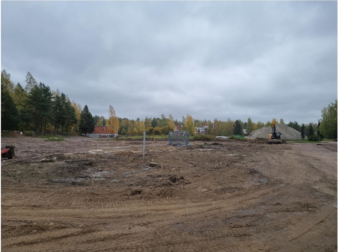
Kuva 9. Yleiskuva Sydänpuunpuiston työmaasta (Mikko Ryyänen)
