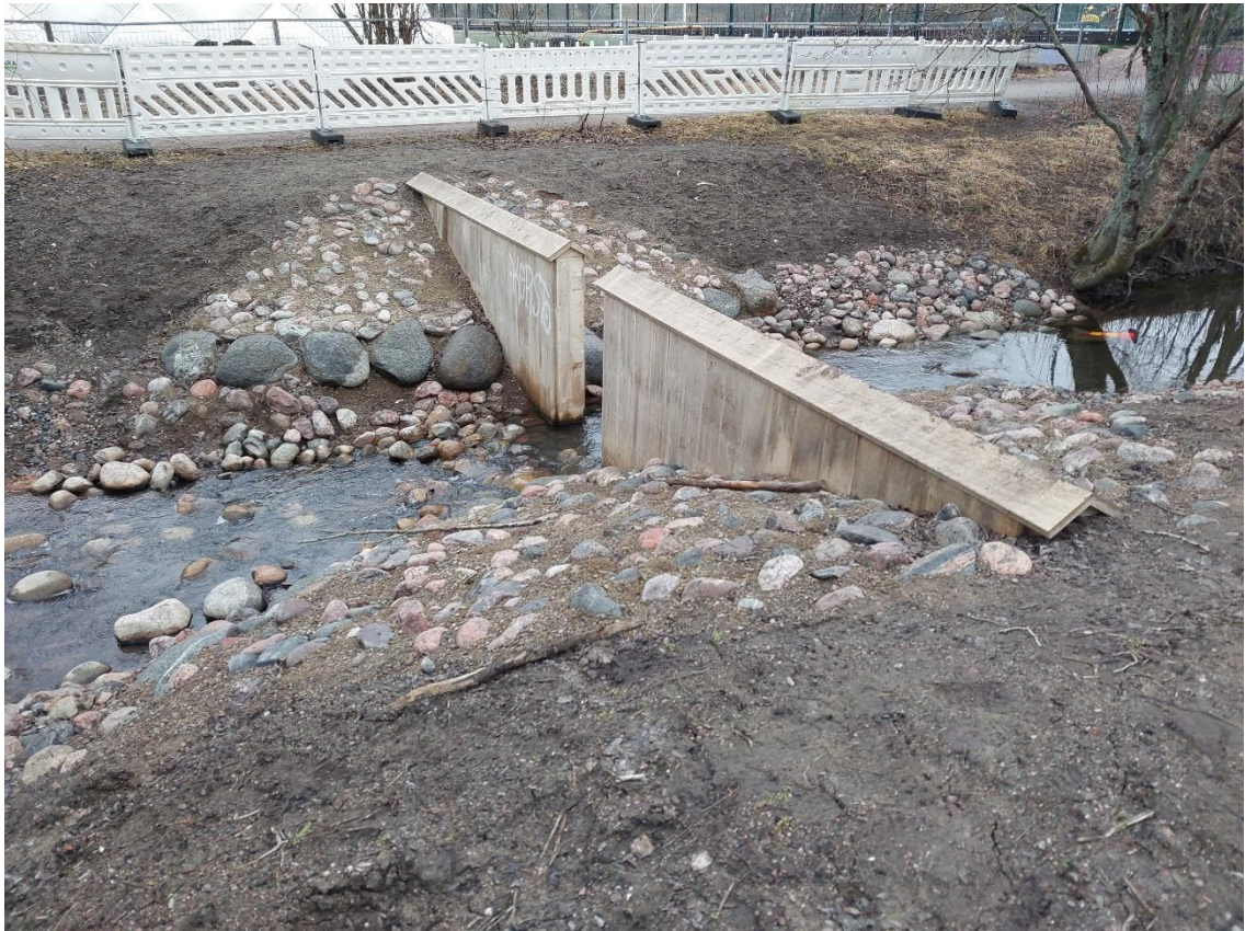
Kuva 15. Virransäätöpato (Mikko Ryyänen)
