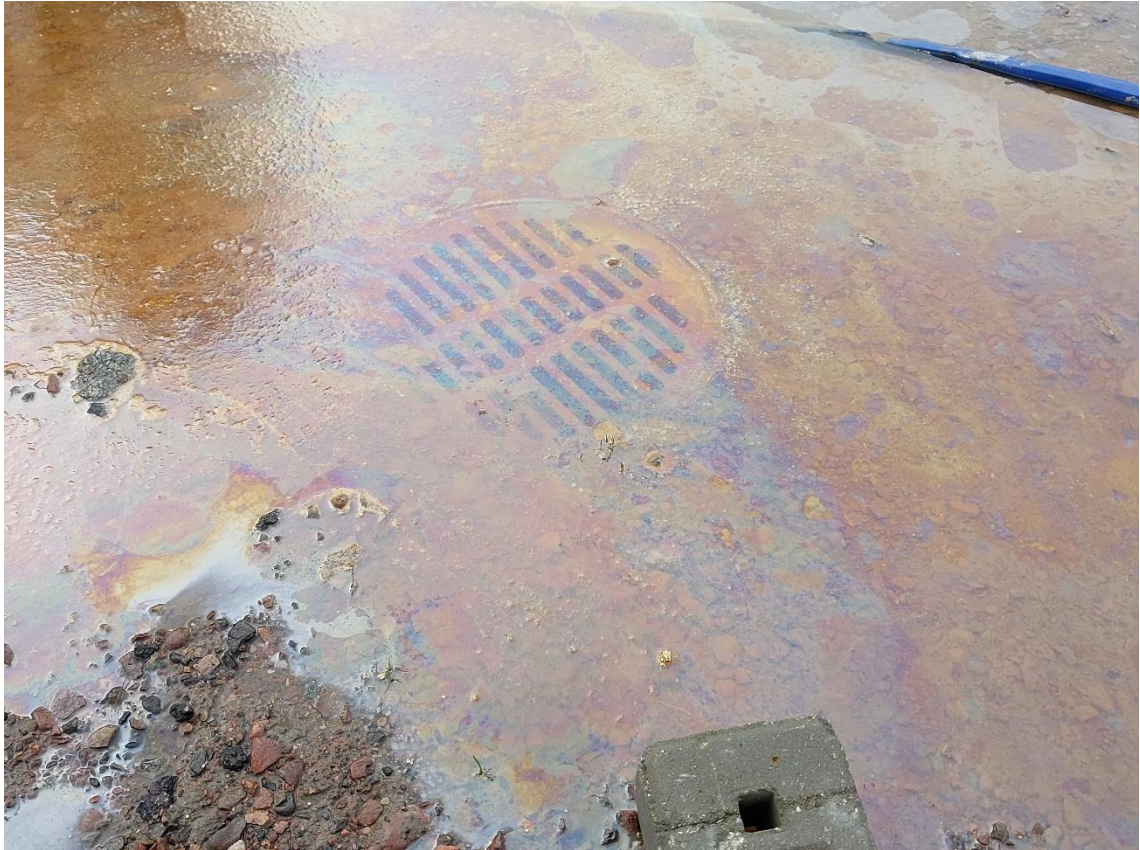
Kuva 12. Hulevesikaivosta noussut öljykalvo (Mikko Ryynänen)
