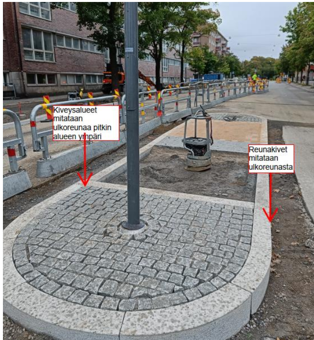
Kuva 29. Reunakivien ja kiveysalueiden mittaaminen (Infra Kiri Oy 2024, muokattu).
