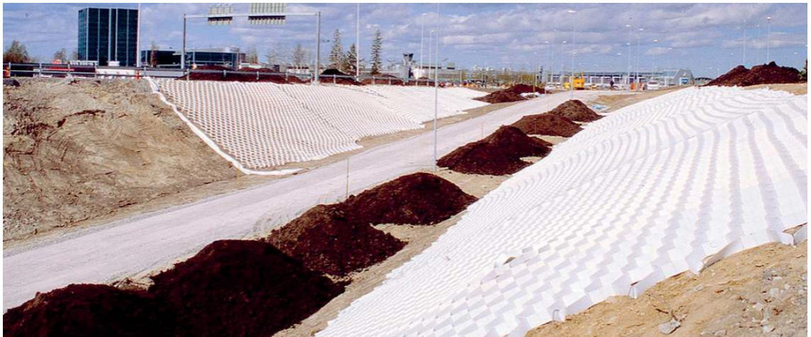
Kuvio 6. Armater-eroosiosuojakennosto asennettuna (Kaitos Oy)
