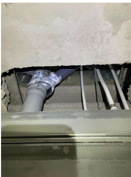
Kuva 7. Työmaalla tehtyjä kylpyhuone-elementtien vesi- ja viemäri-liitoksia, viemäriputken ympärillä palokatkonauhaa. (Kauppinen, 2024.)
