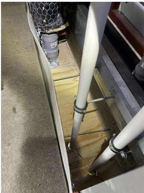
Kuva 8. Tekniikkahormin valumuotti ylhäältä, KVV-putkia ei vielä kokonaan eristetty. (Kauppinen, 2024)
