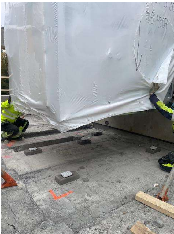
Kuva 6. Kylpyhuone-elementtiä asennetaan kololaattaan, jossa välikkeet oikeassa korossa. (Kauppinen, 2024.)
