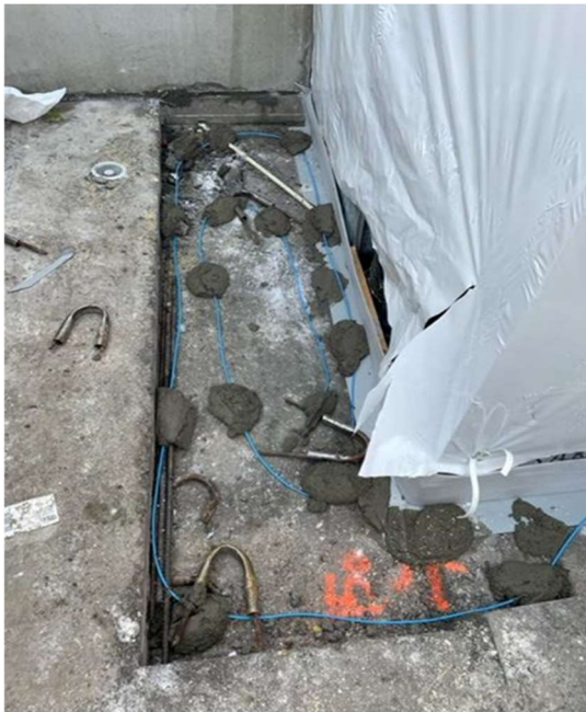
Kuva 14. Kylpyhuone-elementin reuna valuvalmiina. (Kauppinen, 2024.)
