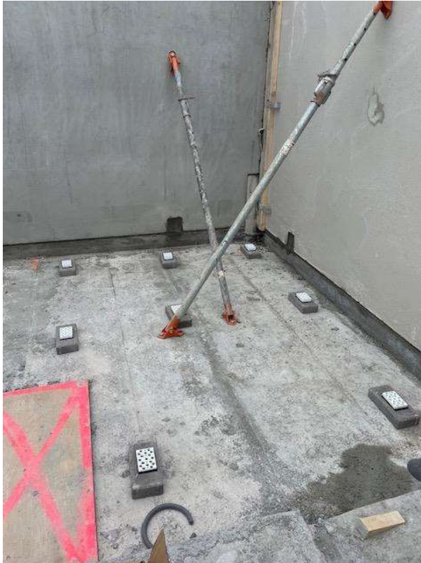
Kuva 4. KPH-elementin alle tulevat välikkeet laitettuna oikeaan korkoon. Vi-notuet ja pystysauman tukko poistetaan ennen asennusta. (Kauppinen, 2024.)
