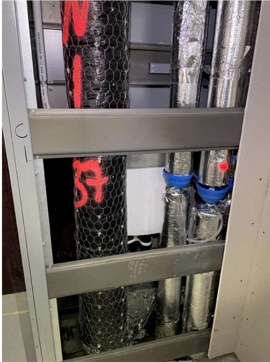
Kuva 15. Tekniikkahormissa eristykset tehty ja vuodonilmaisimet asennettu, jolloin hormin voi levyttää (Kauppinen, 2024)
