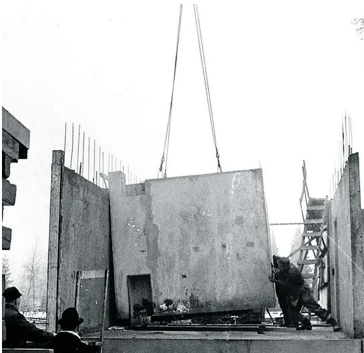
Kuva 2. KPH-elementin asennus Forssassa 1960-luvulla ( https://www.tekniikkatalous.fi )
