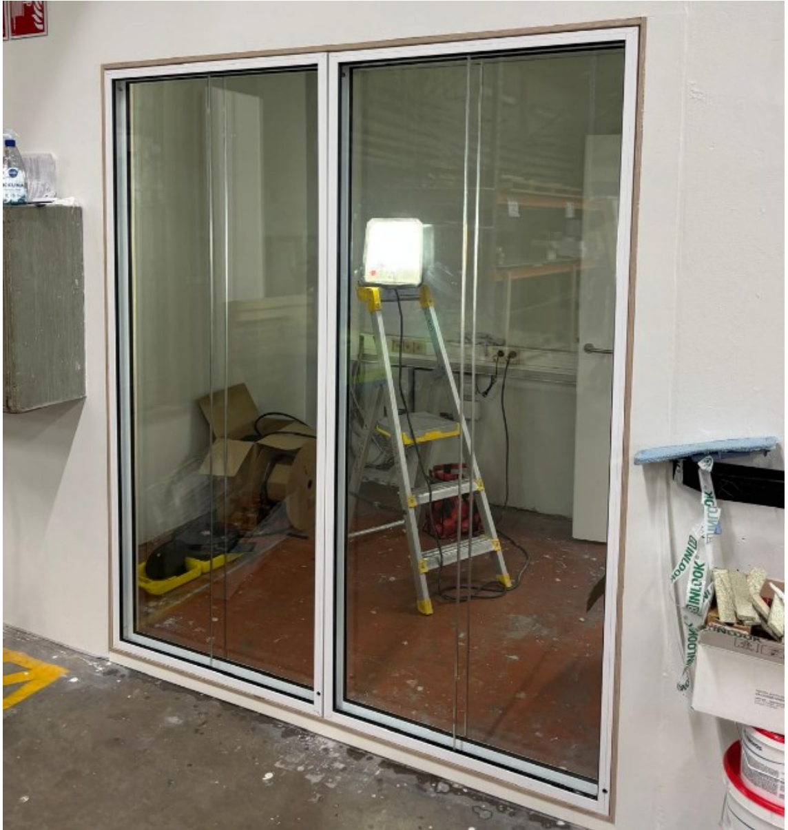
Kuva 14. Saumakittausta vaille oleva Double glazy
