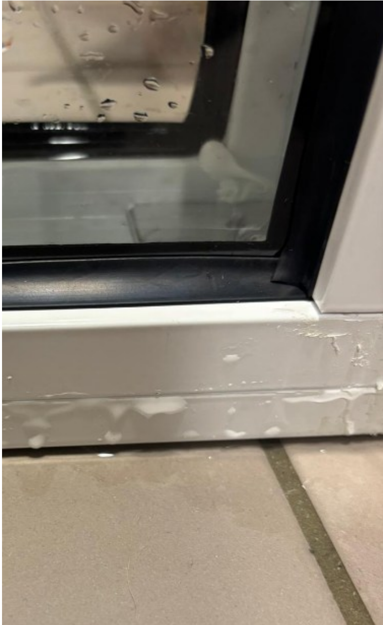
Kuva 19. Lasituslistan välistä tihkuu vettä.
