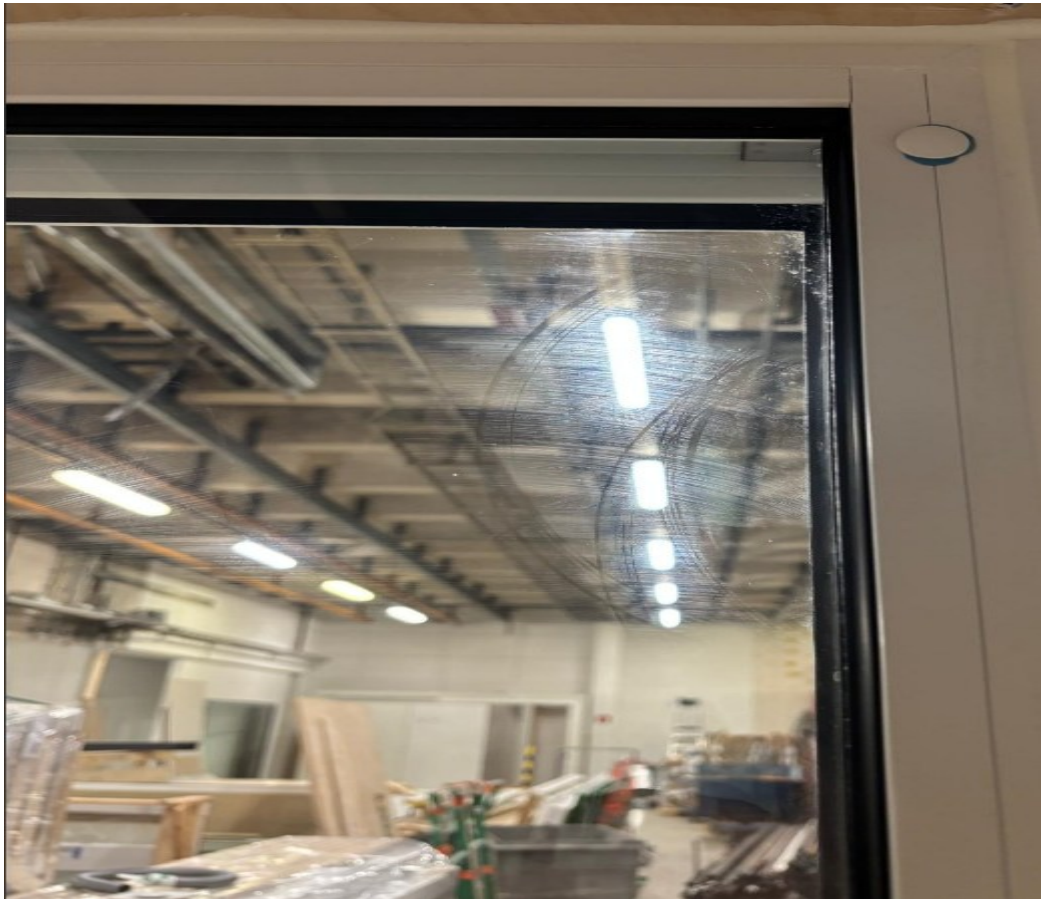
Kuva 16. Imukupinjäljet lasien välissä.
