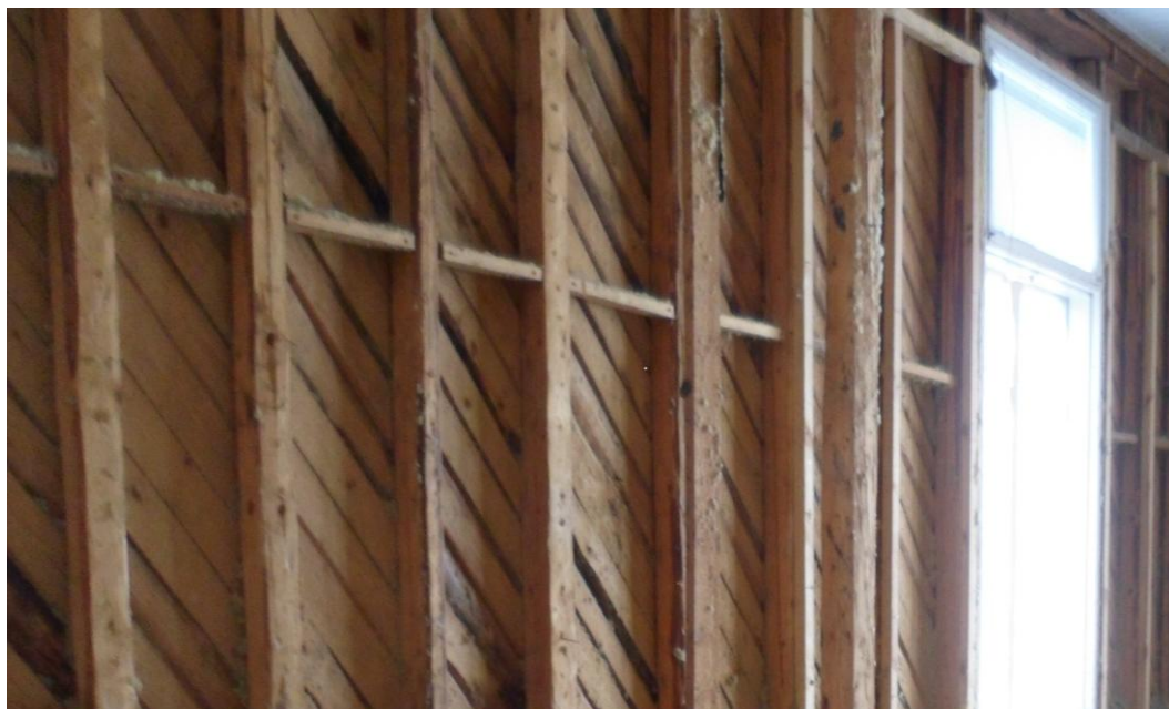
Kuva 10. Vanhoista eristeistä purettua seinärakennetta rakennuksen laajennusosalla. Vinolaudoitus jäykistää rakennuksen rungon (Kokkonen 2014)
