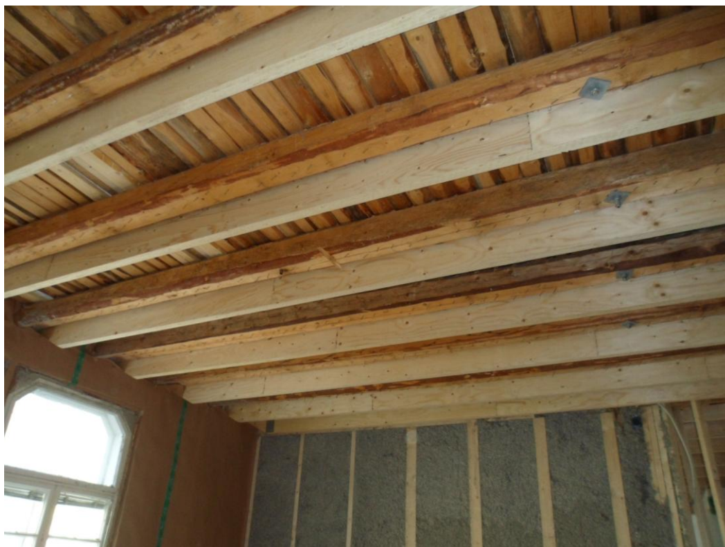
Kuva 21. Kuvassa näkyy kuinka ikkunat suuresta huonekorkeudesta huolimatta ulottuvat lähes laipioon saakka. (Kokkonen 2014)
