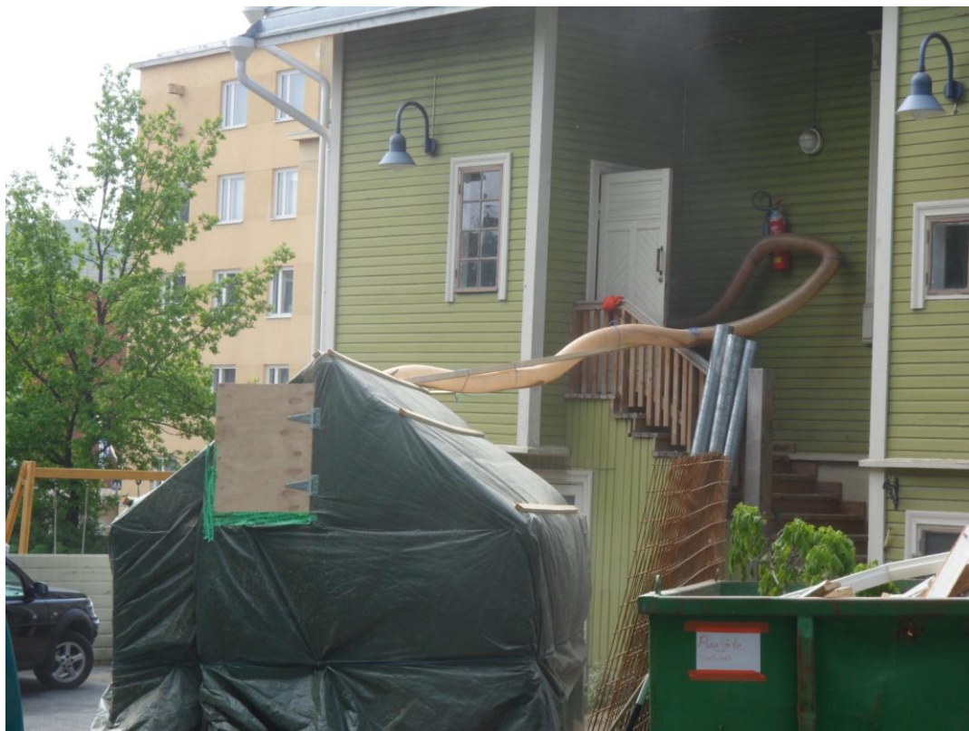
Kuva 19. Huputettu jätelava johon vanha eriste imuroidaan. (Kokkonen 2014)
