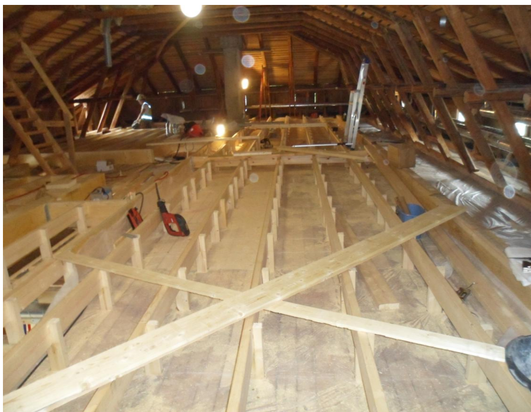
13. Uutta lattiarakennetta ullakkohuoneiden osalla. (Kokkonen2014)
