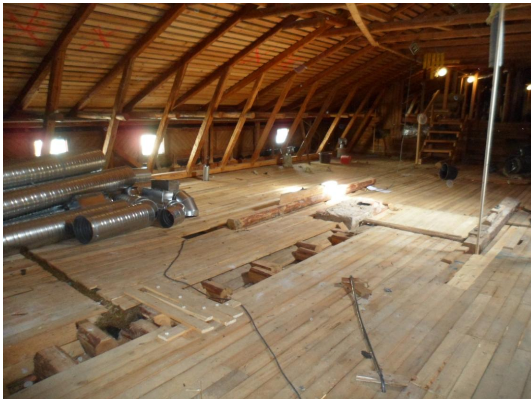
Kuva 12. Vanhoista eristeistä puhdistettua ullakkotilaa. (Kokkonen 2014)
