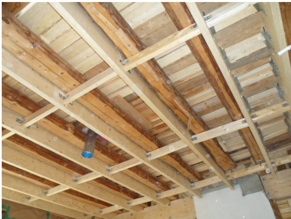
Kuva 20. Välipohjapalkisto lisätuettuna (Kokkonen 2014)
