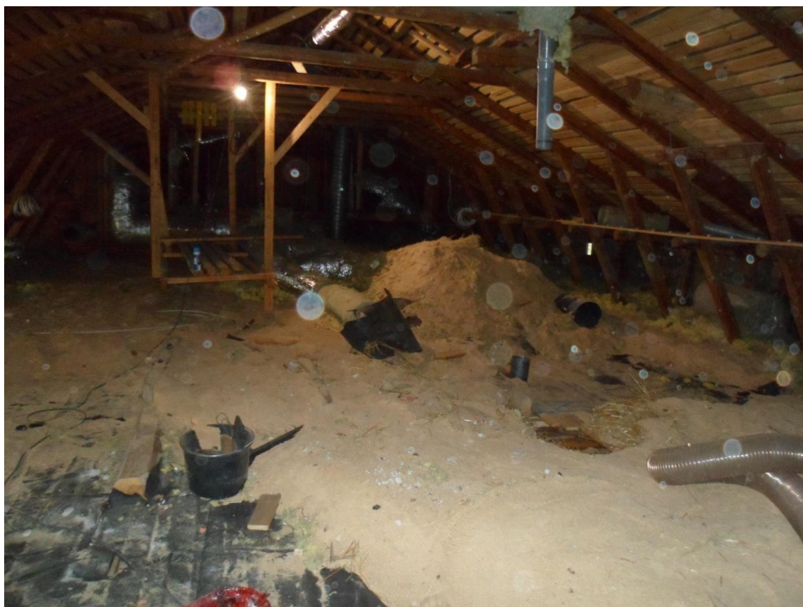
Kuva 11. Vanhan eristeen poistotyöt kesken ullakolla. (Kokkonen 2014)
