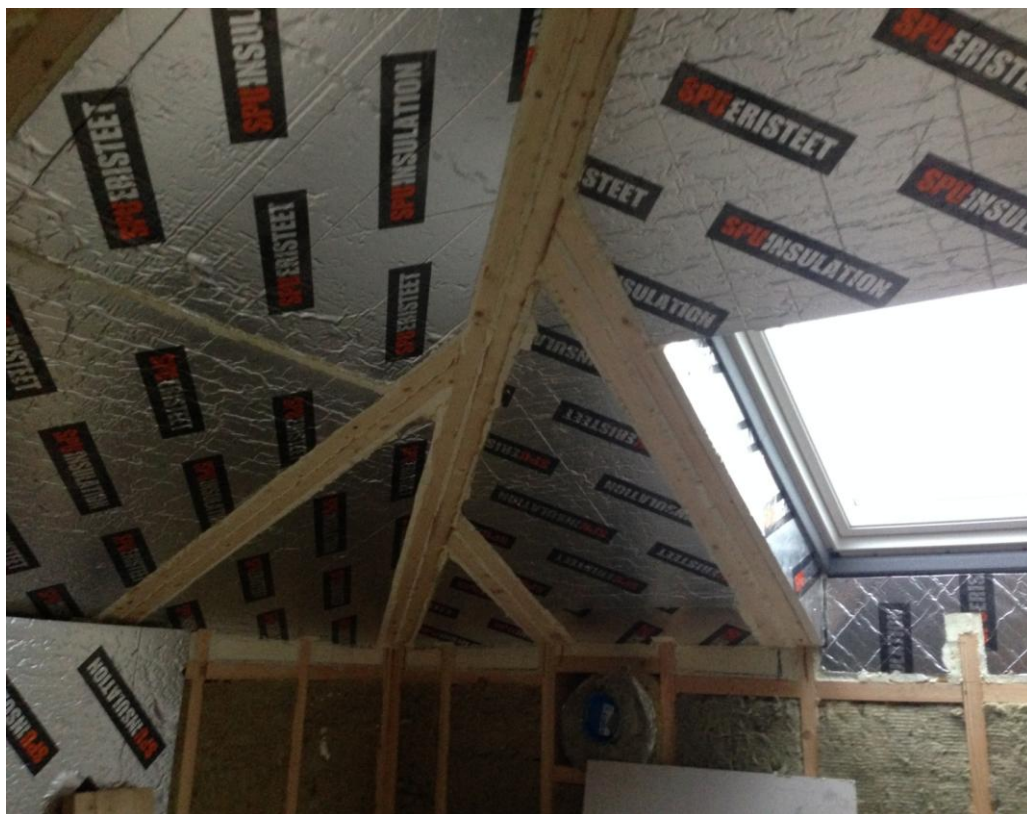
Kuva 14. Yläpohjan lämmöneristys toteutetaan SPU levyillä tilan säästämiseksi. (Kokkonen 2014)
