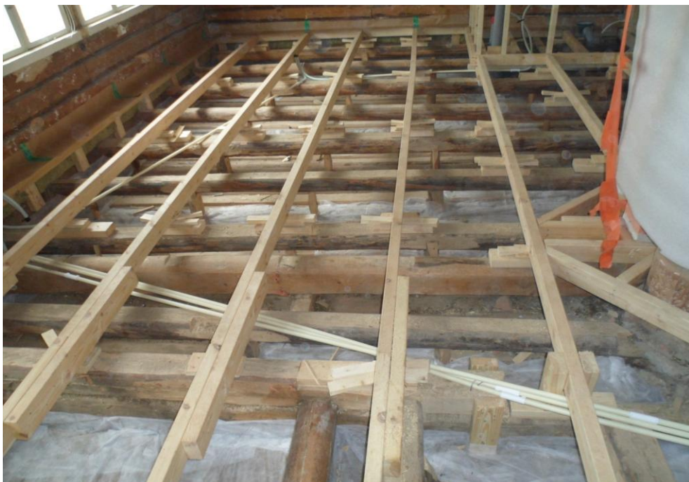
Kuva 7. Eristetila odottaa selluvillan puhallusta (Kokkonen 2014)
