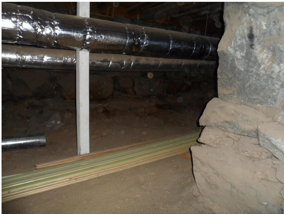
Kuva 15. Alapohjassa kulkevaa eristettyä viemärointiä (Kokkonen2014)
