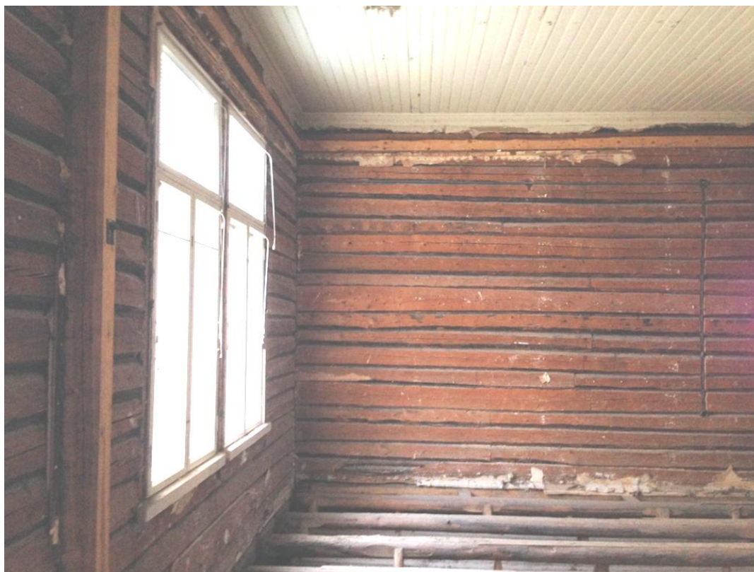
Kuva 9. Näkyviin purettua ulko- ja väliseinää (Kokkonen2014)
