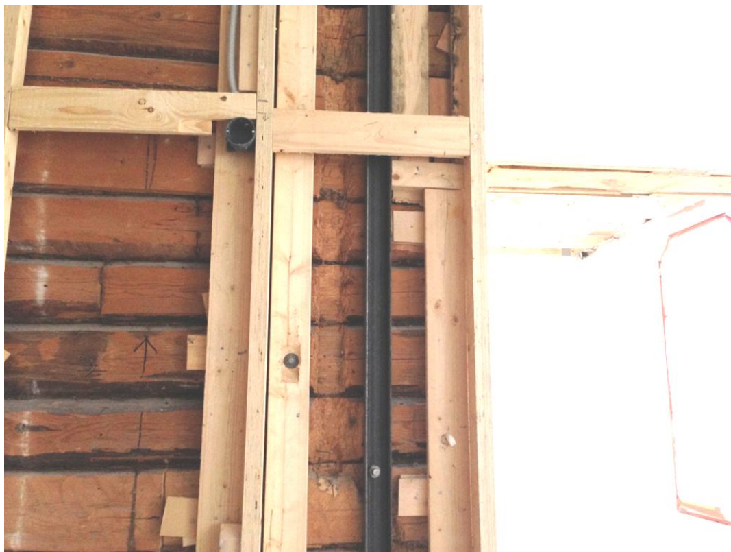
Kuva 18. U-raudalla oikaistua vanhaa väliseinä hirsirakennetta (Kokkonen 2014)
