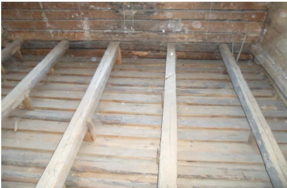
Kuva 6. Vanhasta eristeestä puhdistettua eristetilaa (Kokkonen 2014)
