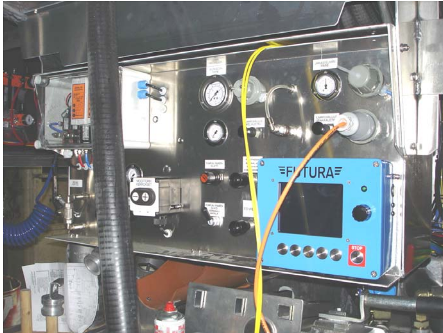
Kuva 67. Eurotank Oy:n kehittämän Futura-ohjausyksikön käyttöpaneeli
