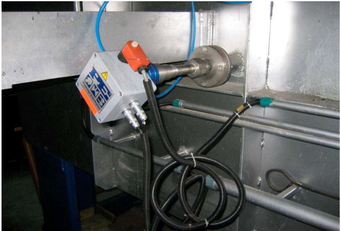
Kuva 18 Happisondi uuniin asennettuna /3/
