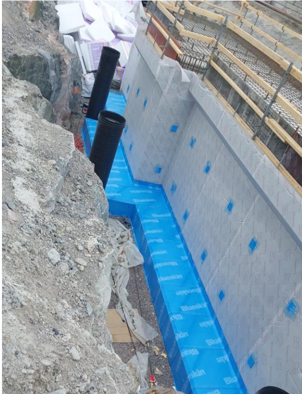
Kuva 5. Zemseal tuotepiheellä vedeneristetty maanalainen tunneli. [luku 7][25]
