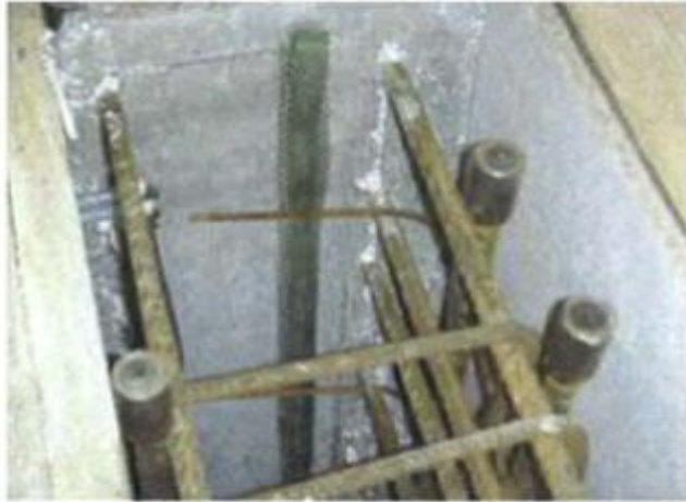
Kuva 10. Paisuvan saumanauha sijoittaminen työsaumaan [11]
