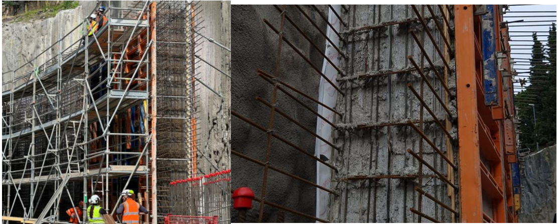
Kuva 18. T1-tunnelin seinän työsaumat
