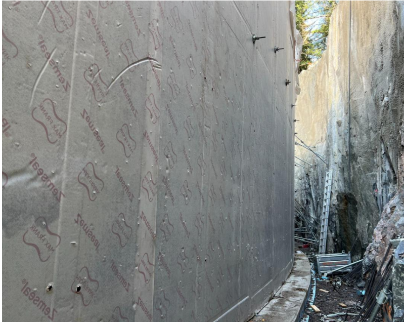
Kuva 20 T1-tunnelin seinän ulkopuolinen vedeneristys.
