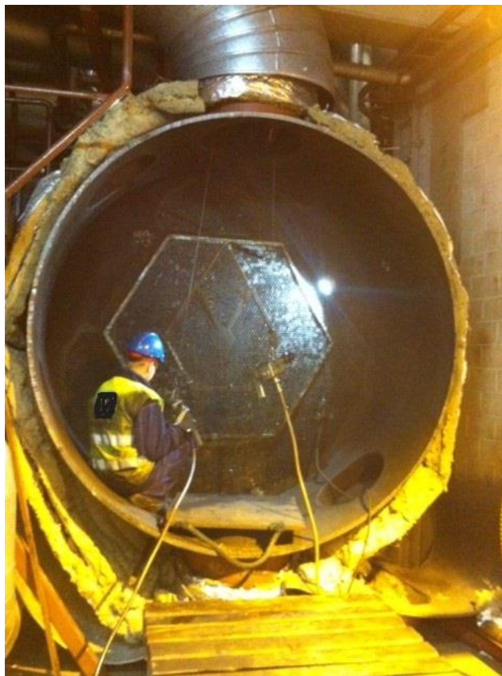
KUVA 1. Joensuun voimalaitoksen kaukolämmösiirtimen pääty avattuna v.2014. (Väyrynen 2015.)
