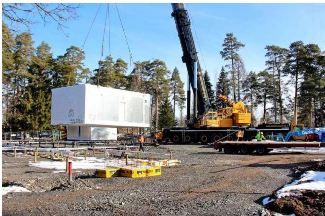
KUVA 1. Moduulien asennustyöt käynnissä. (Kiviranta 2022).
