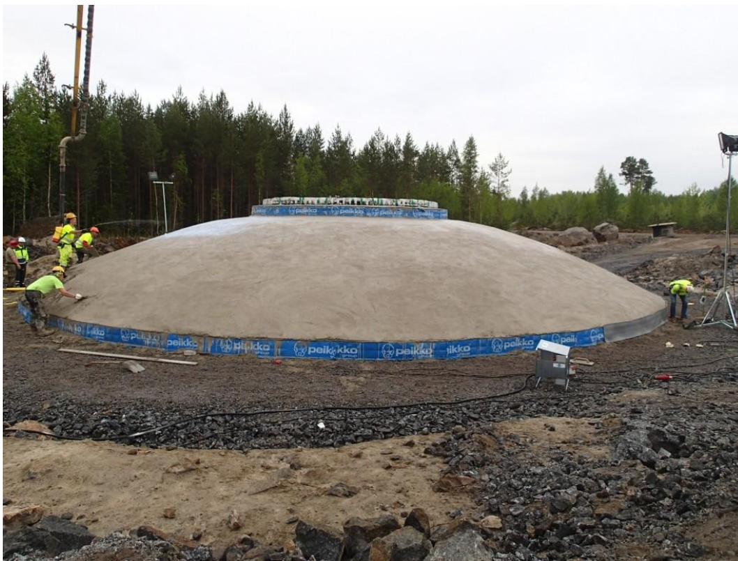
Kuva 11. Valmiiksi hierretty perustus.
