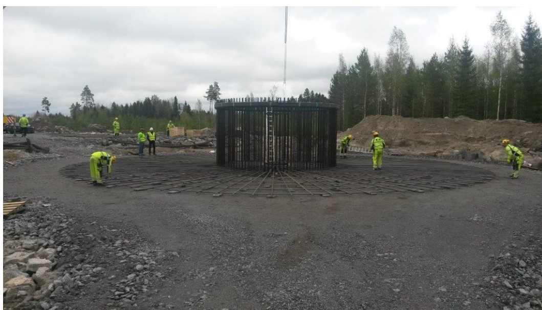
Kuva 3. Pulttikehikon pystytys.
