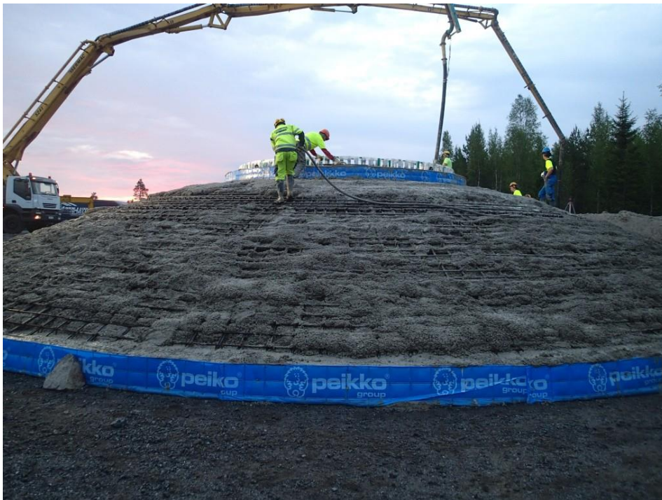
Kuva 9. Betonointi lähes valmis.
