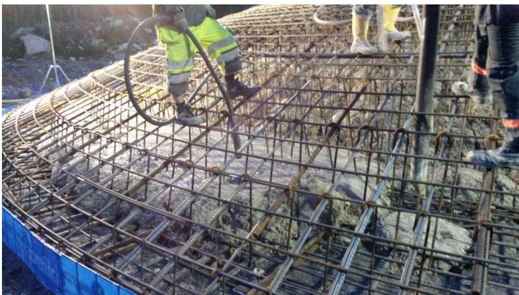
Kuva 8. Betonoinnin tiivistäminen.
