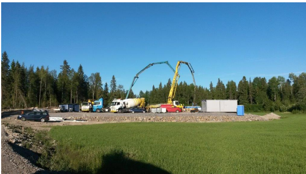
Kuva 6. Perustuksen betonoinnin työmaa.
