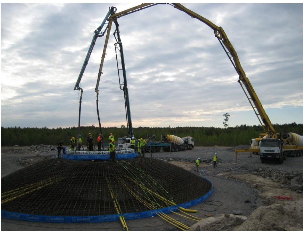
Kuva 7. Betonoinnin aloittaminen.
