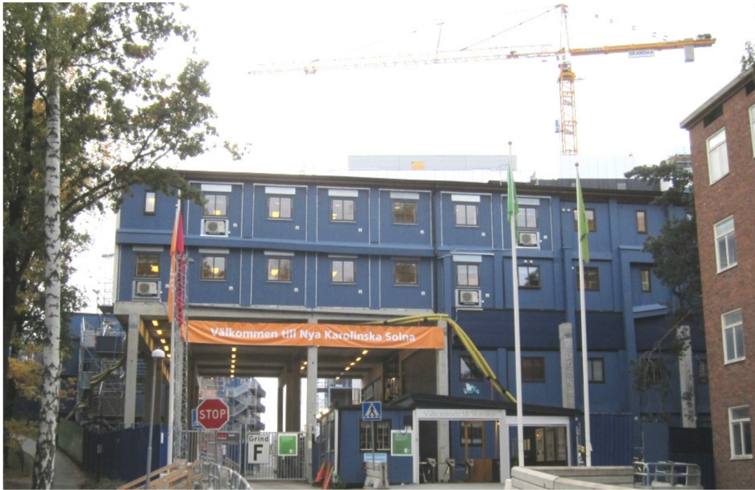
Kuva 8. Nya Karolinska Solna -sairaalan odotuspaikkana toimiva työmaa-alueen portti.
