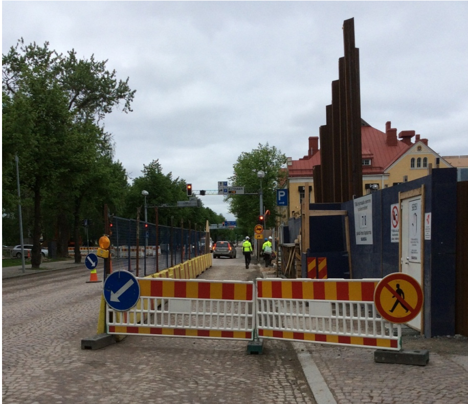
Kuva 9. Läpiajettava purkupaikka Skanskan työmaalla Oulussa
