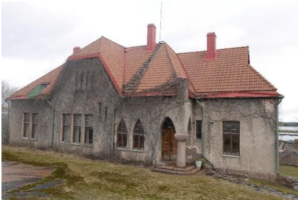
Kuva 1. Yleiskuva vanhan pääkonttorin julkisivusta
