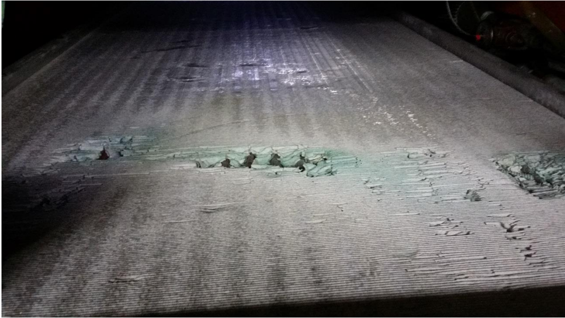
KUVA 16. Glykoli LTO:n patterin hapettuminen. Patteri on vihertävää hapettumakerrostuman peitossa ja murenee jo pelkällä sormikosketuksella.
