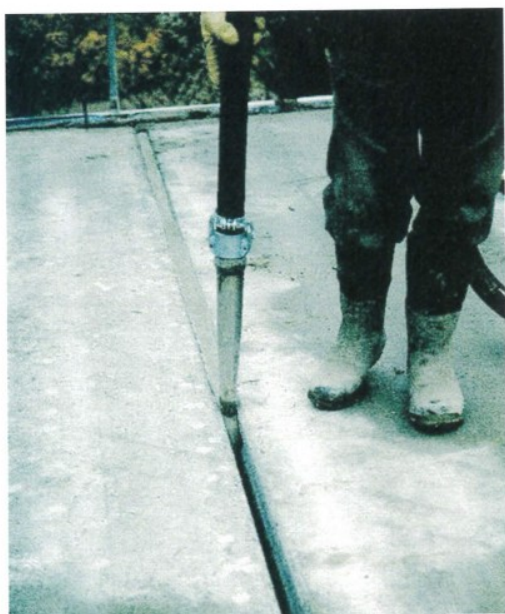
Kuva 17. Saumojen pumppaus ruuvisekoittimella (Suomen Betonitieto, 2002)
