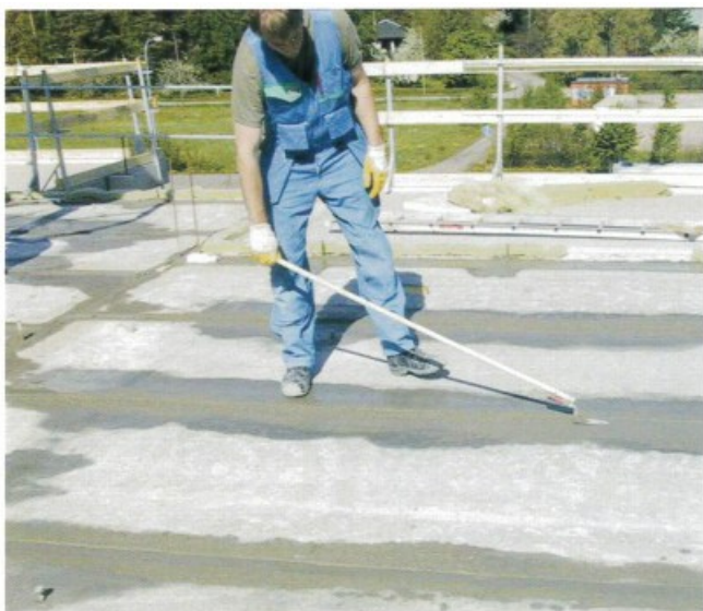
Kuva 16. Saumauksen jälkeinen siivous. (Suomen Betonitieto, 2002)
