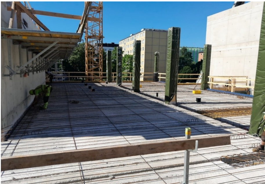
Kuva 5. Kuorilaataston raudoitusta
