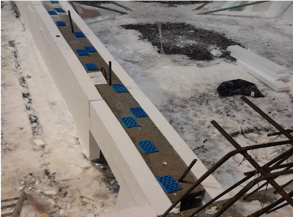
Kuva 12. Ontelolaattaa kantava seinä
