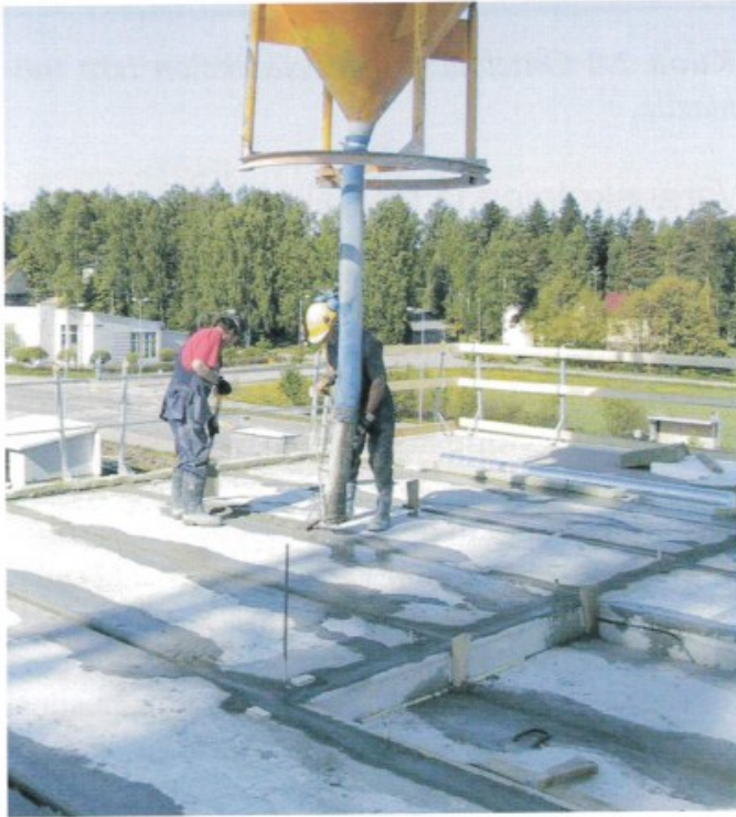
Kuva 15. Laataston saumavalu nostoastialla. (Suomen Betonitieto, 2002)
