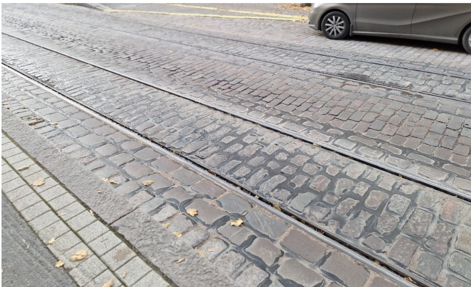
Kuva 15 Nupukivien uutta bitumointia ja nupukivien painuminen kiskopariien
