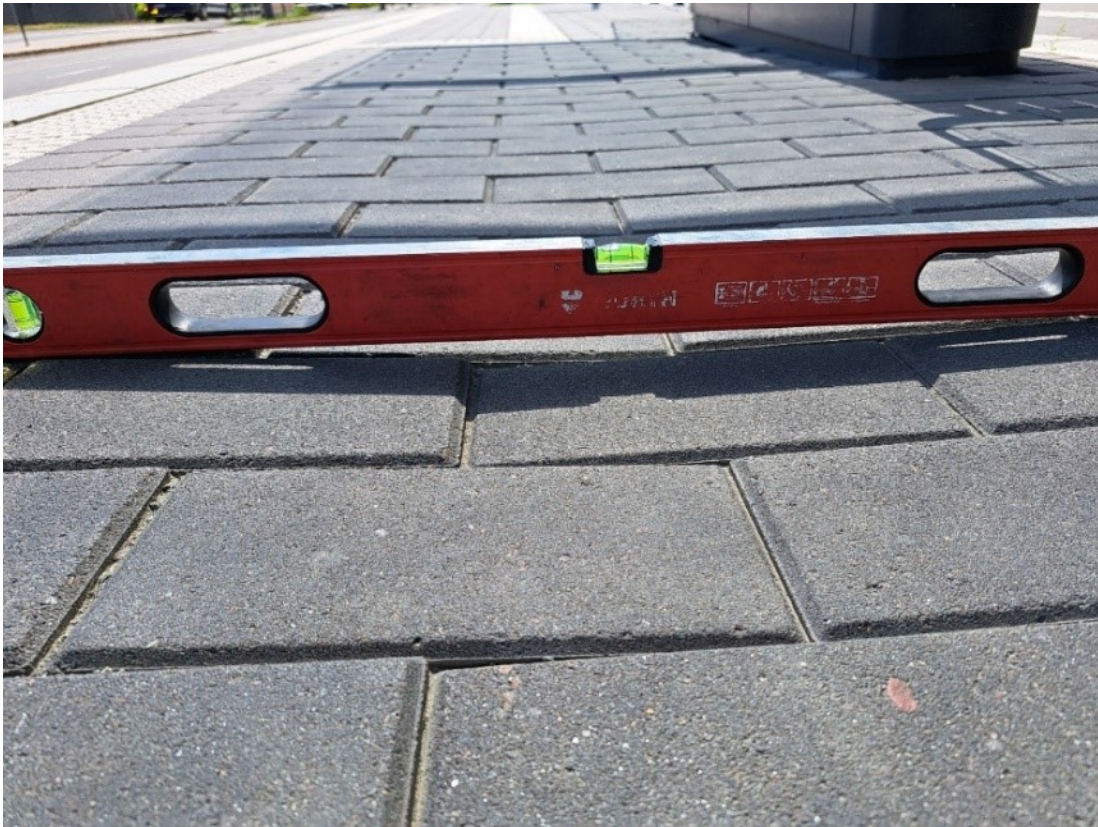
Kuva 24 Tampereen raitiotiepysäkin kivien painuminen havainnollistettu vatupassin avulla
