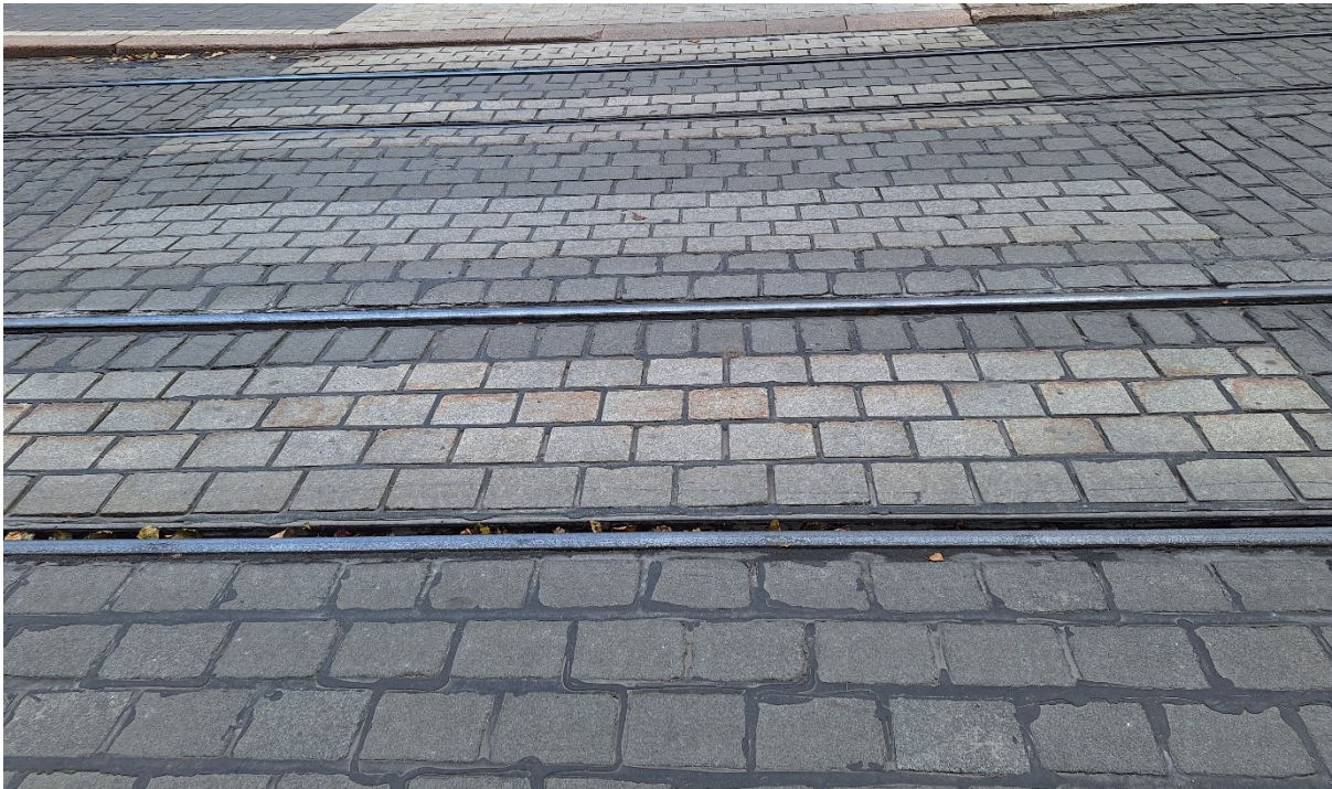
Kuva 13 Telakkakadulla suojatien nupukiviä käännetty 90°
