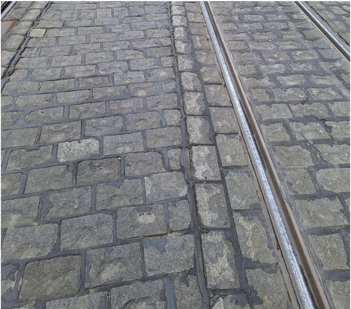
Kuva 12 Telakkakadun painunutta ja liikkunutta nupukiveystä
