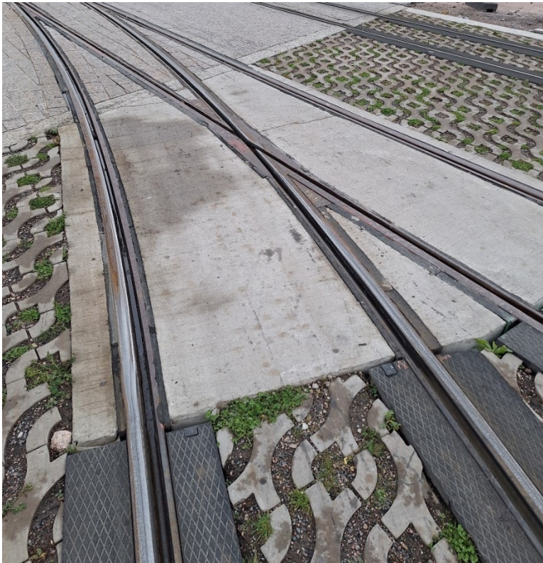
Kuva 3 Nurmikiveys ja ratakiskojen kapeiden välien betonointi Nihdin alueelta
