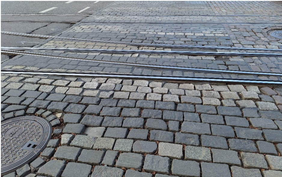
Kuva 14 Bulevardin ja Hietalahdenkadun risteuksen suojatie tehty nupukivistä
