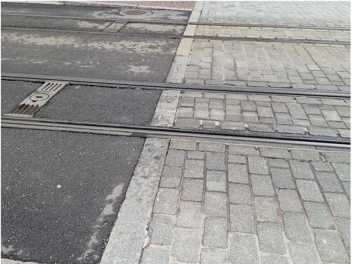
Kuva 7 Leonkadun upotettu reunatuki asfaltin ja nupukiveyksen rajapinnassa
