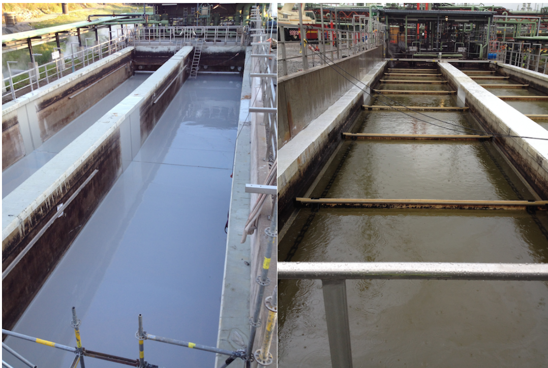
Kuva 15. Uutuuttaan kiiltävä pinnoite. Kuva 16. Käytössä oleva korjattu allas.
