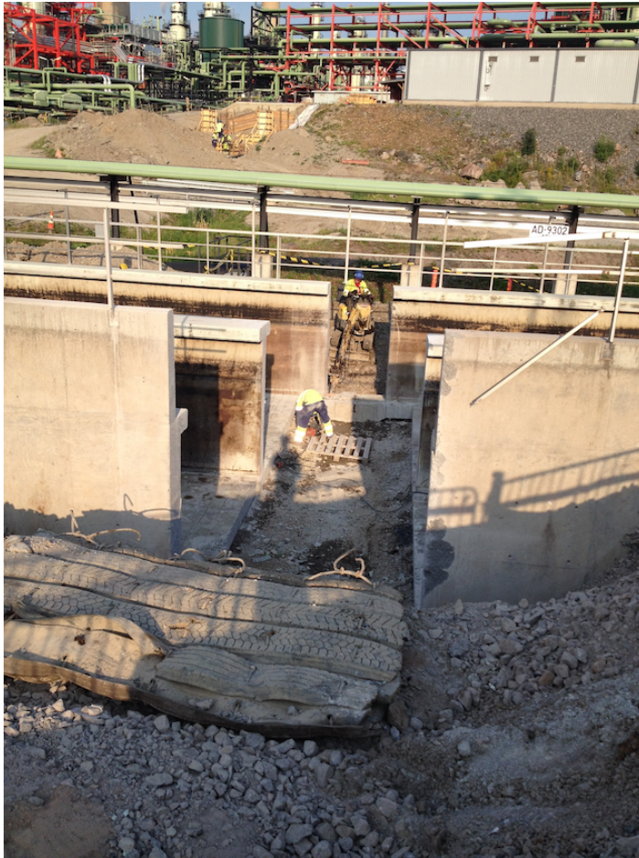
Kuva 5. Altaan rakenteiden viimeistä purettavaa osaa irrotetaan.
