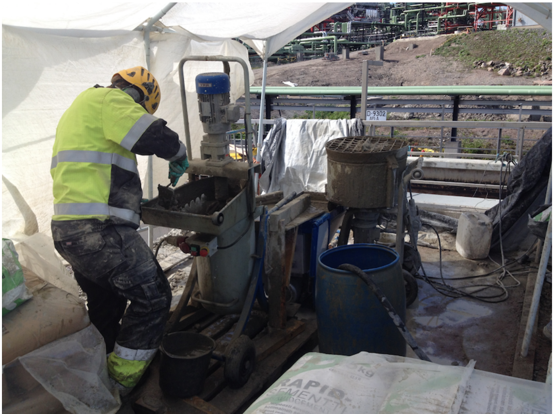
Kuva 10. Kaksi sekoitinta ja yksi injektointipumppu valmiudessa.
