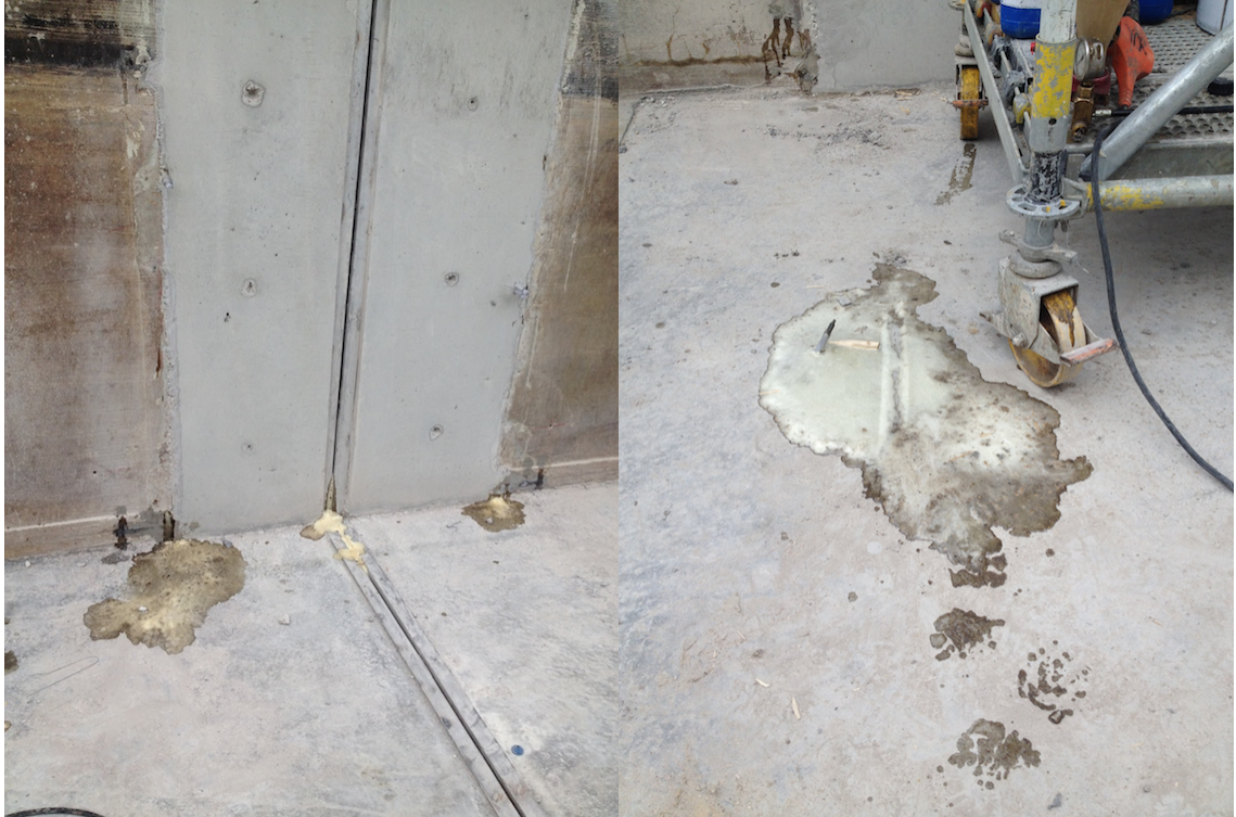
Kuvat 11 ja 12. Liikuntasaumavalun injektointiletkut täynnä hartsia.
