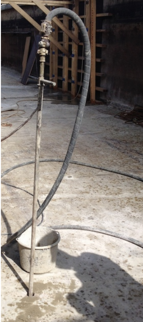
Kuva 9. Injektointiletku kiristettynä injektointireikään.
