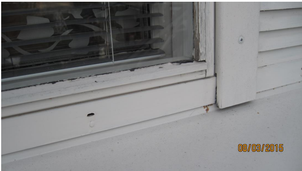
Kuva 8. Ikkuna rakennuksen pohjoispuolella.
