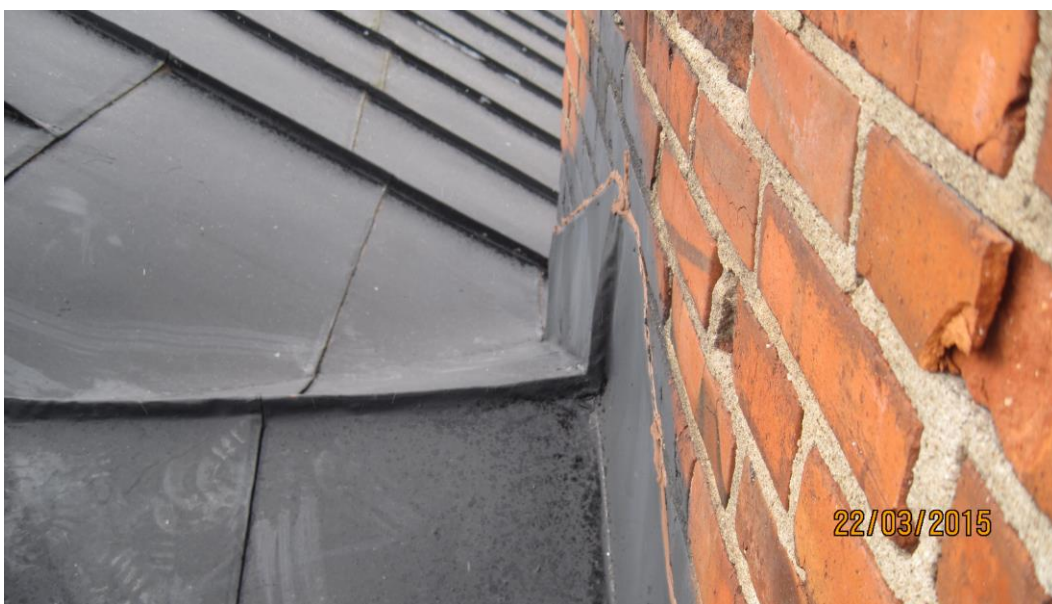
Kuva 16. Savuhormin läpiviennin tiivistys.
