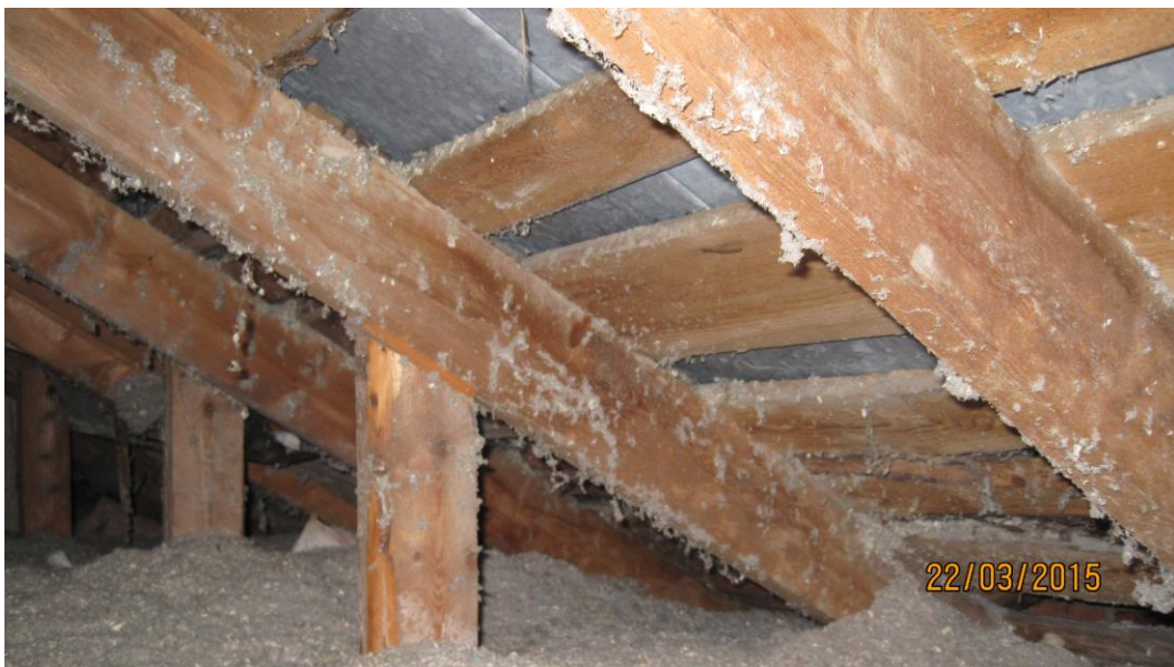
Kuva 12. Yläpohjan eriste tukkii tuuletuksen
