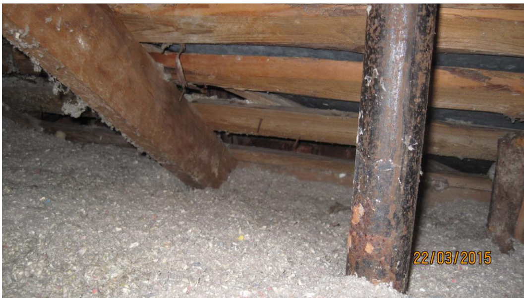
Kuva 18. Viemärin tuuletusputki eristämättä yläpohjassa.
