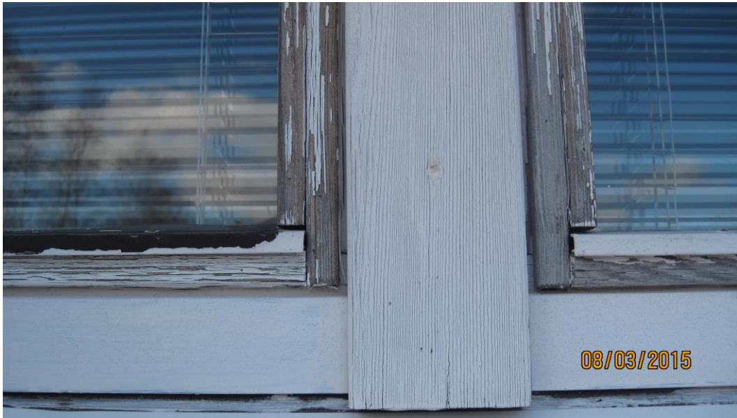
Kuva 7. Ikkuna rakennuksen eteläpuolella.
