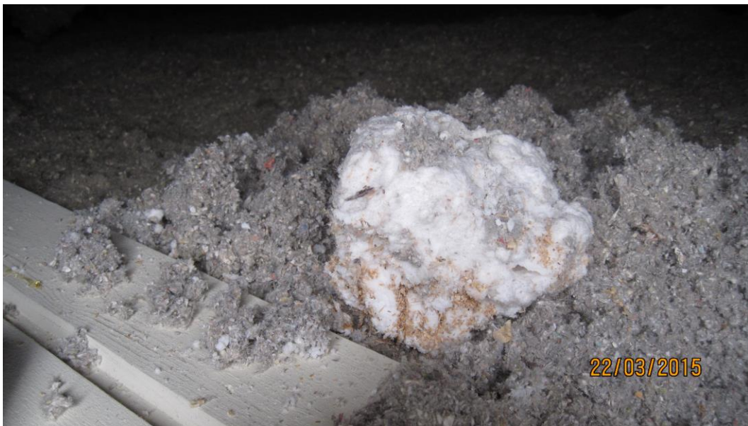
Kuva 11. Paakkuuntunutta puhallusvillaa yläpohjassa.
