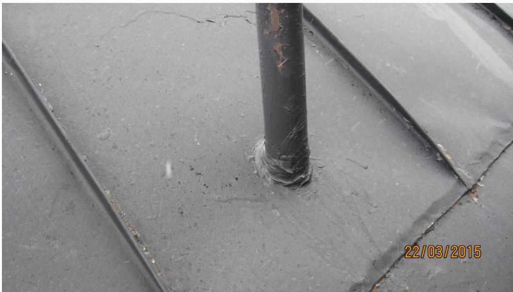
Kuva 17. Viemärin tuuletusputken läpiviennin tiivistys.
