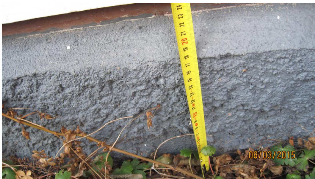
Kuva 10. Kellarin ikkunan etäisyys maahan.
