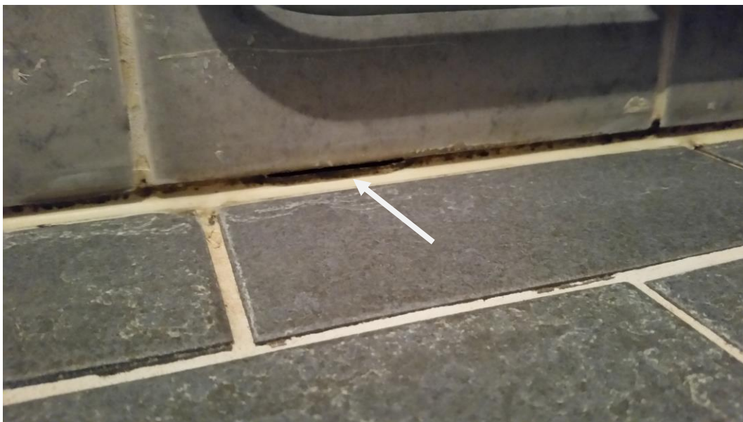
Kuva 20. Silikonisauma ei peitä kokonaan lattia- ja seinälaatoituksen väliä.
