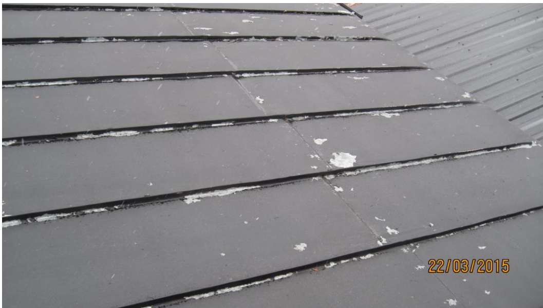
Kuva 19. Konesaumakatteen maalin rapistumista.
