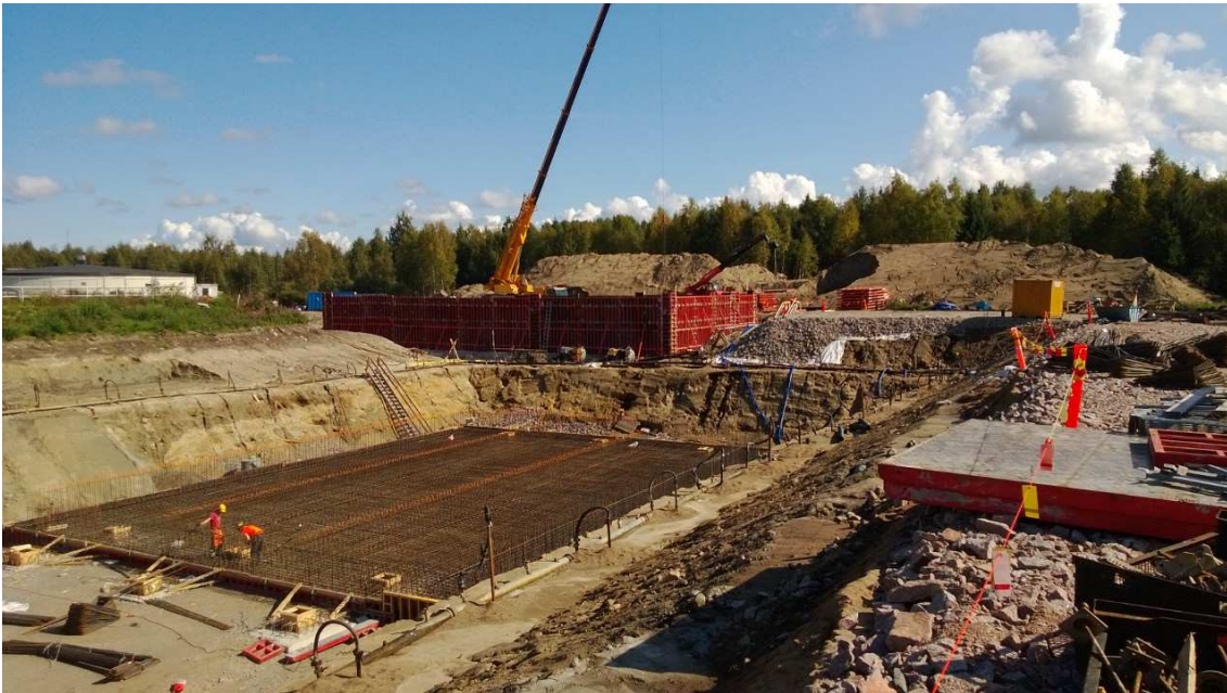
KUVA 11. Maanvaraisenlaatan raudoitus ja muottityö
