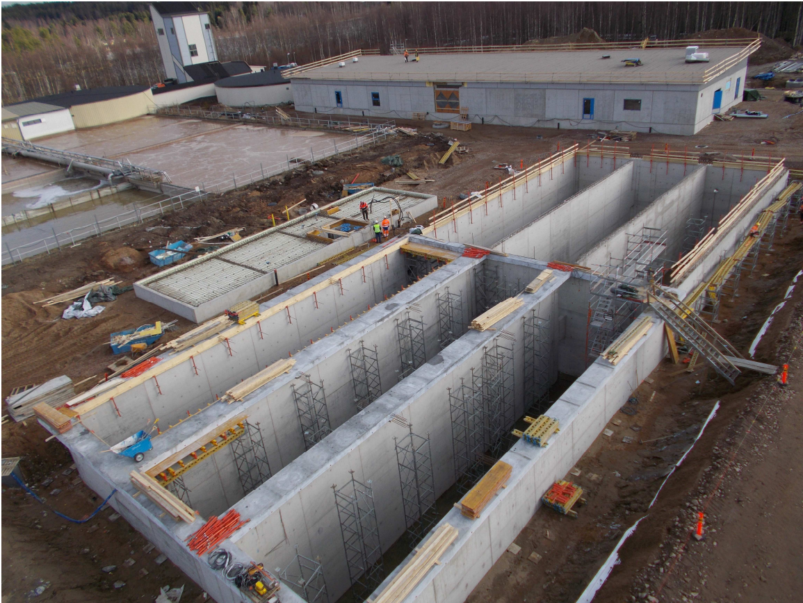
KUVA 7. Ilmakehu Haapaveden jätevedenpuhdistamon rakennusalueesta
