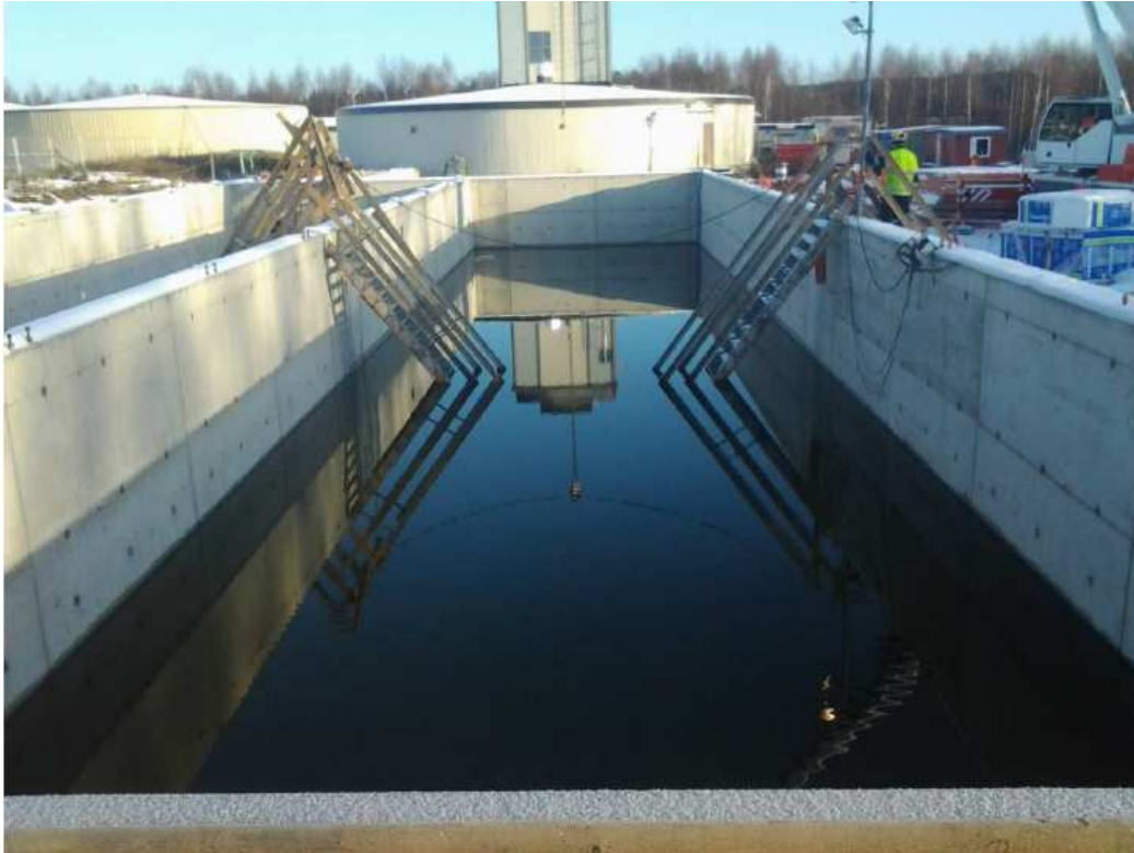
KUVA 10. Väliselkeytinallas täytettynä
