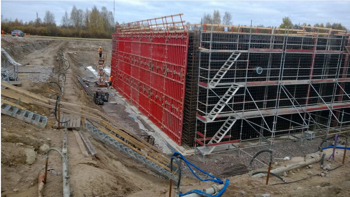
KUVA 12. Altaiden seinien raudoitus ja muottityö etelästä katsottuna
