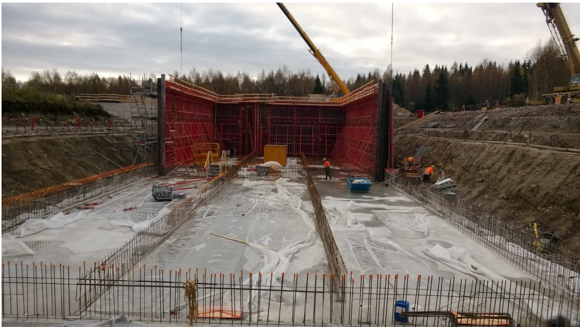
KUVA 12. Altaiden seinien raudoitus ja muottityö etelästä katsottuna
