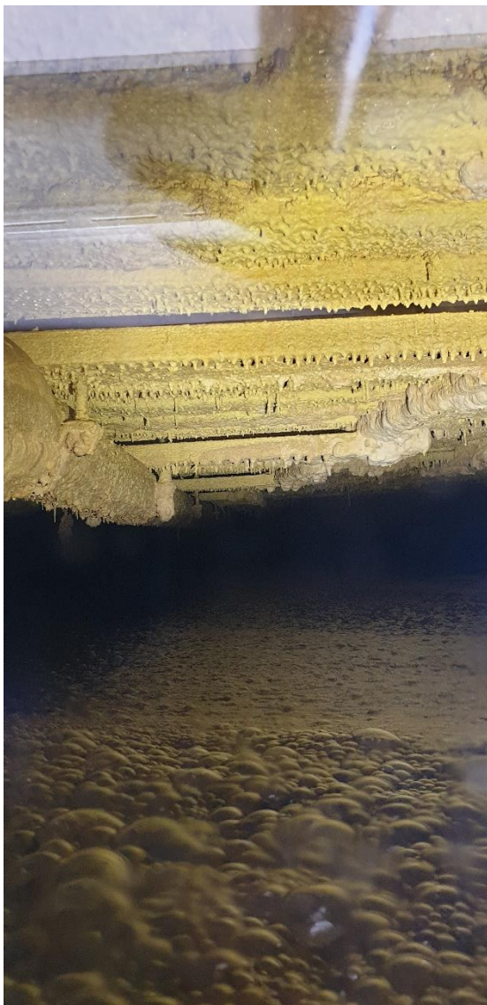
Kuva 2. Näkymä lietesäiliöön räjähdyskestävän lasin takaa.
