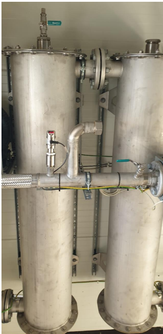
Kuva 3. Aktiivihiilisuodattimet. Suodattimet sijaitsivat lietesäiliön tarkkailukopissa.
