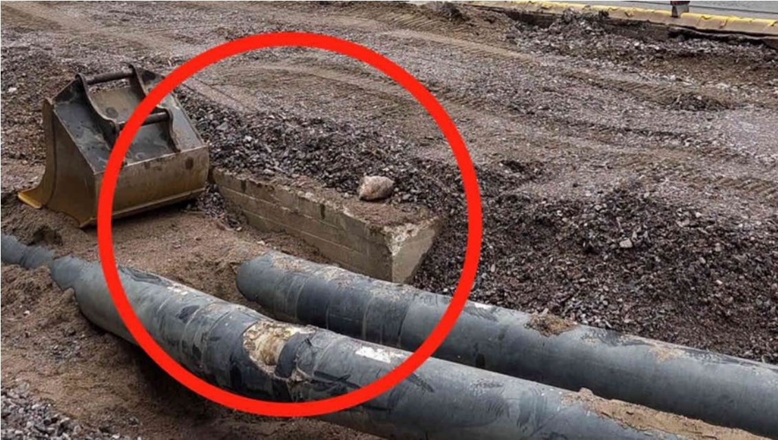
Kuva 12. Kruunusillat hanke. Löytynyt väestönsuoja kaivutöiden yhteydessä. [22.]
