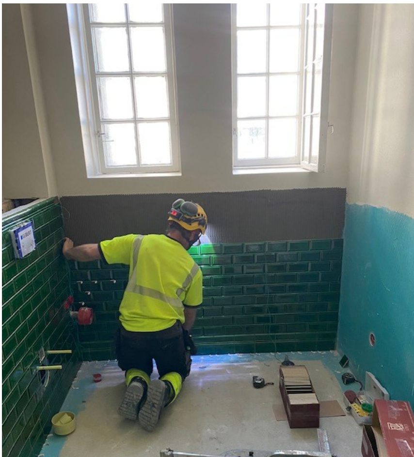
Kuva 8. WC-tilojen laatoitustyöt käynnissä.
