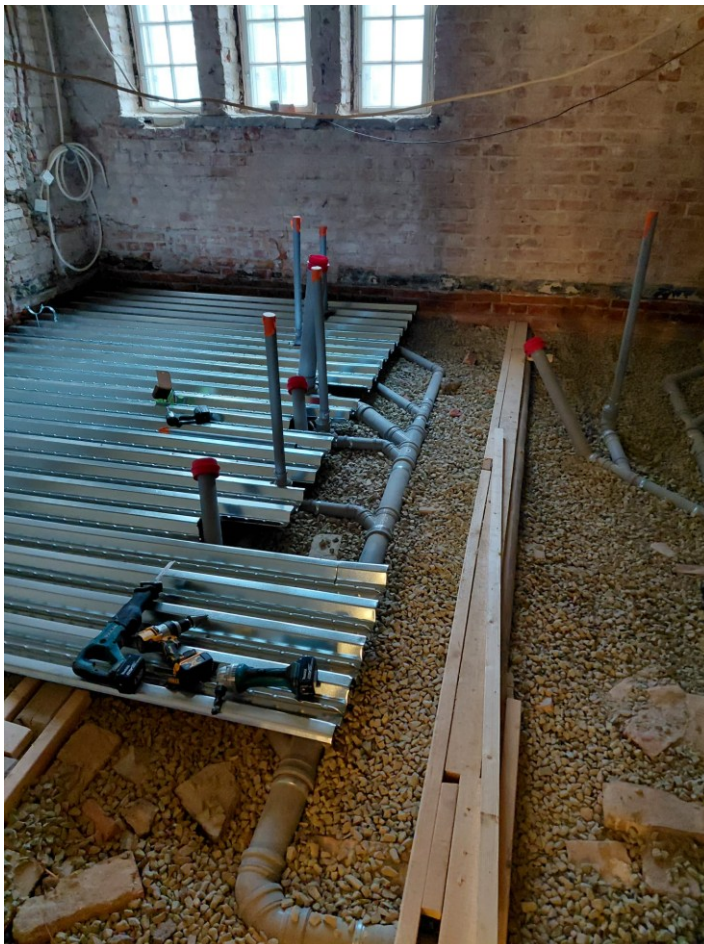
Kuva 9. WC-tilojen uuden välipohjarakenteen liittolaattojen asennus käynnissä.
