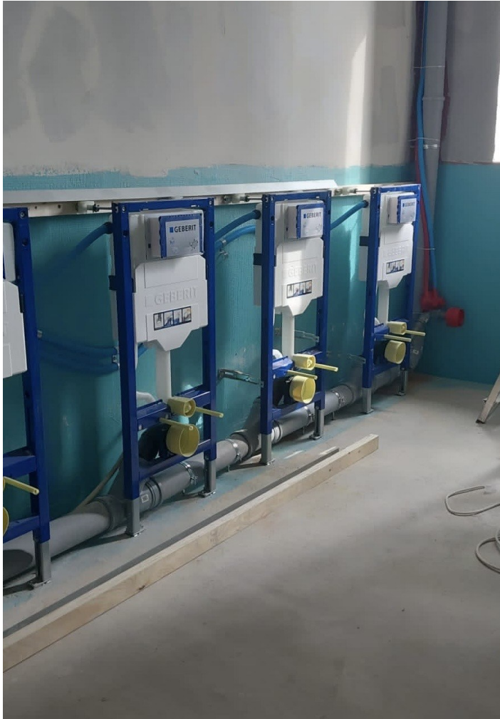
Kuva 10. Vedeneristetty pisuaarien tausta.
