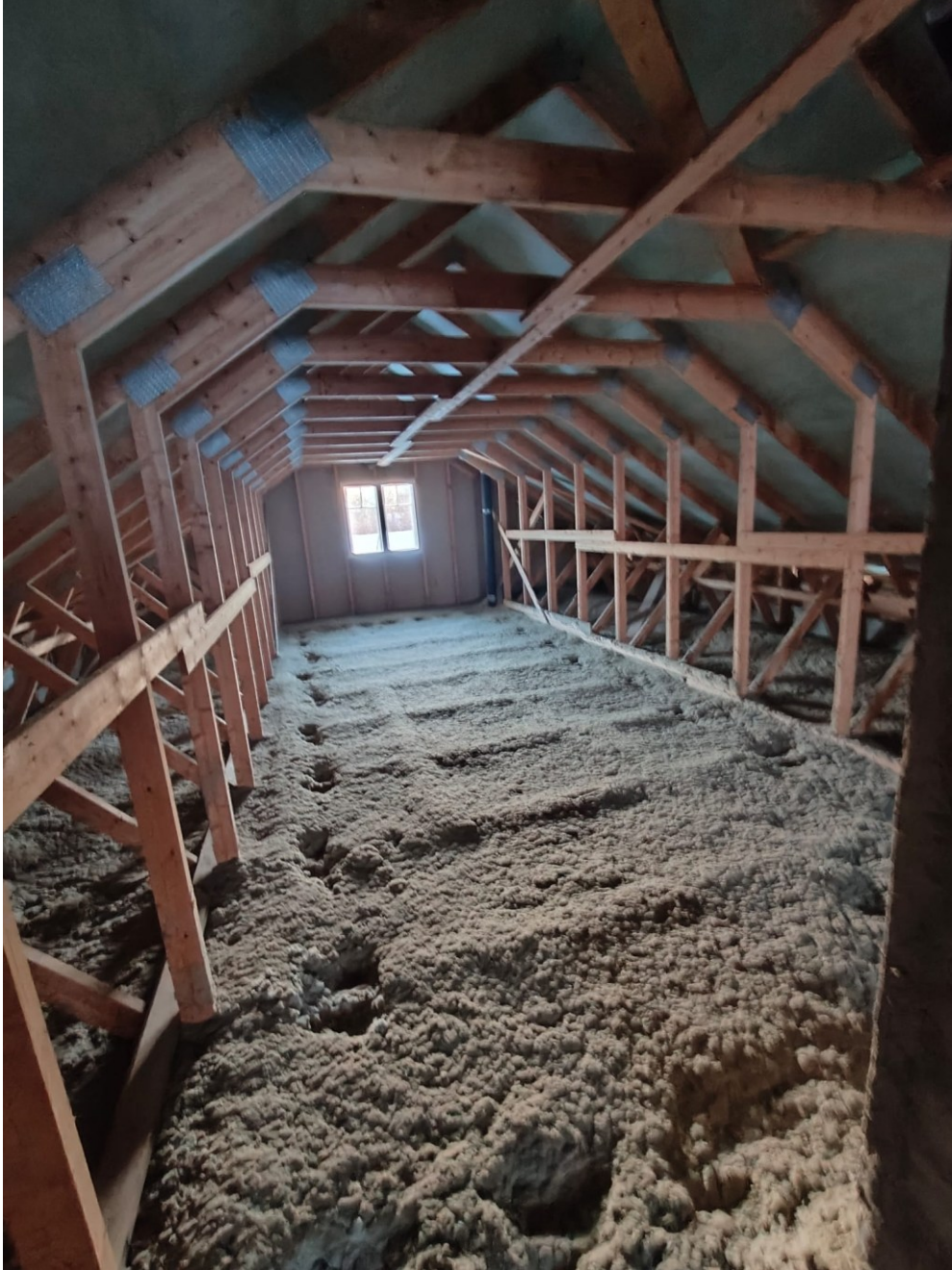
Kuvio 4. Rakennuksen ullakko
